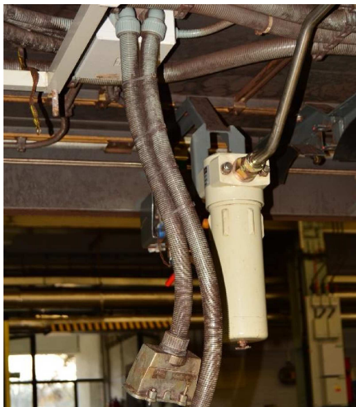
Obrázek 5: Instalace mikrofiltru na podvozku vozu M1
