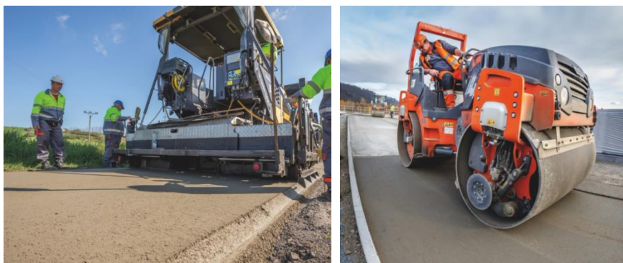
Obr. 10: pokládka pomocí finišeru (vlevo), hutnění válcem (vpravo) [14]
