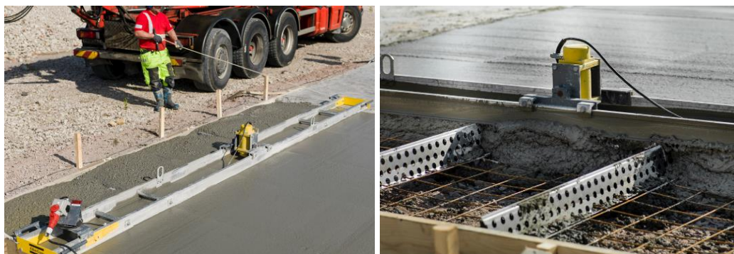
Obr. 19: Vibrační lišta (posun po kolejnicích) [22]
