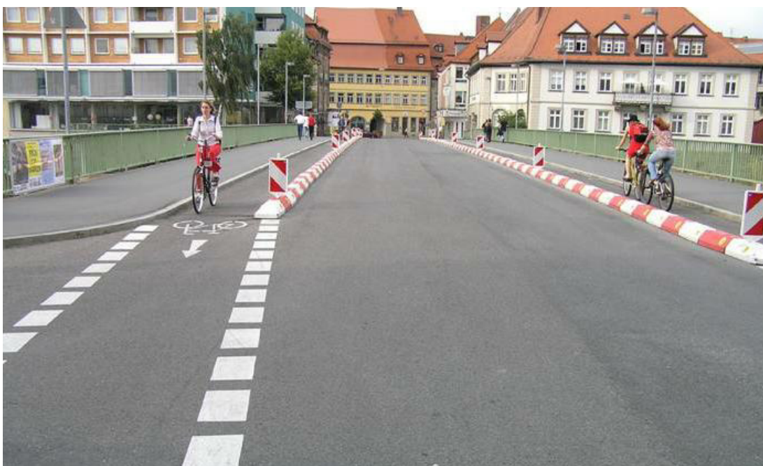
Obrázek 24 – Bamberg, Německo – aplikované fyzické oddělení v hlavním dopravním prostoru v místě mostu (zdroj: TP 179) [10]
