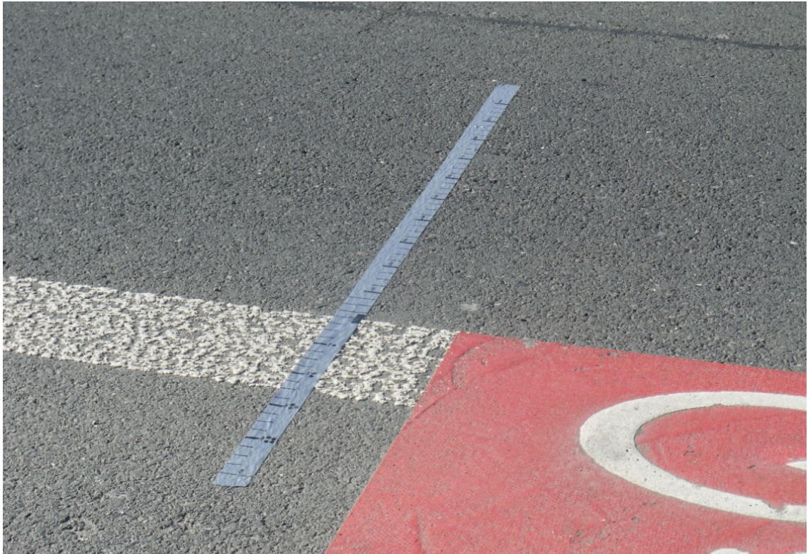
Obrázek 69 – Měření průjezdné vzdálenosti motorových vozidel, detail (zdroj: Ing. Jiří Drbohlav)
