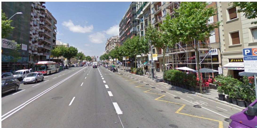
Obrázek 19 – Barcelona, Španělsko - fyzické oddělení jízdnic pruhů pro cyklisty od podélného parkování na čtyřproudé komunikaci (zdroj: Google Street View) [16]
