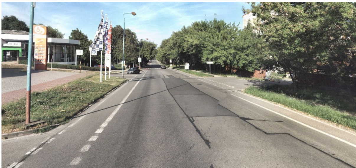
Obrázek 122 – Olomouc, ulice Hněvotínská (zdroj: Google Street View) [16]
