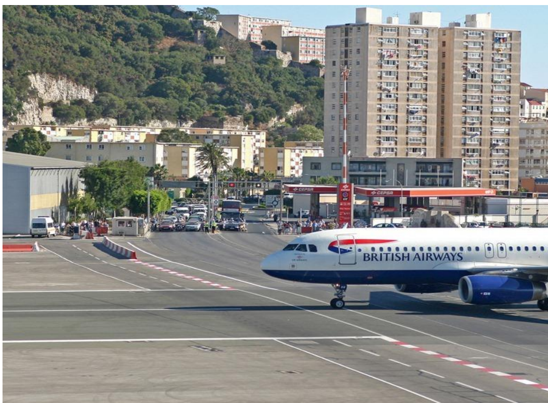
Obrázek č. 1 – Komunikace křižující vzletovou a přistávací dráhu Gibraltar International Airport, zdroj: [3]
