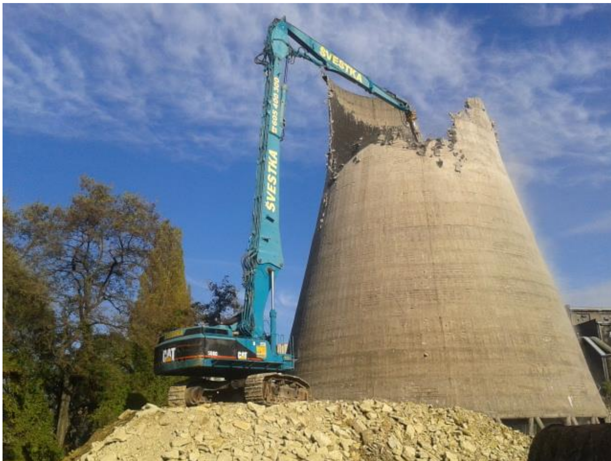
Obrázek 31: Demolice chladicí věže těžkou strojní technikou
