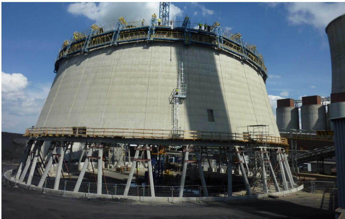
Obrázek 26: Výstavba chladicí věže pomocí posuvného bednění
