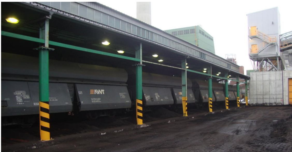
Obrázek 33: Nové ocelové sloupy
