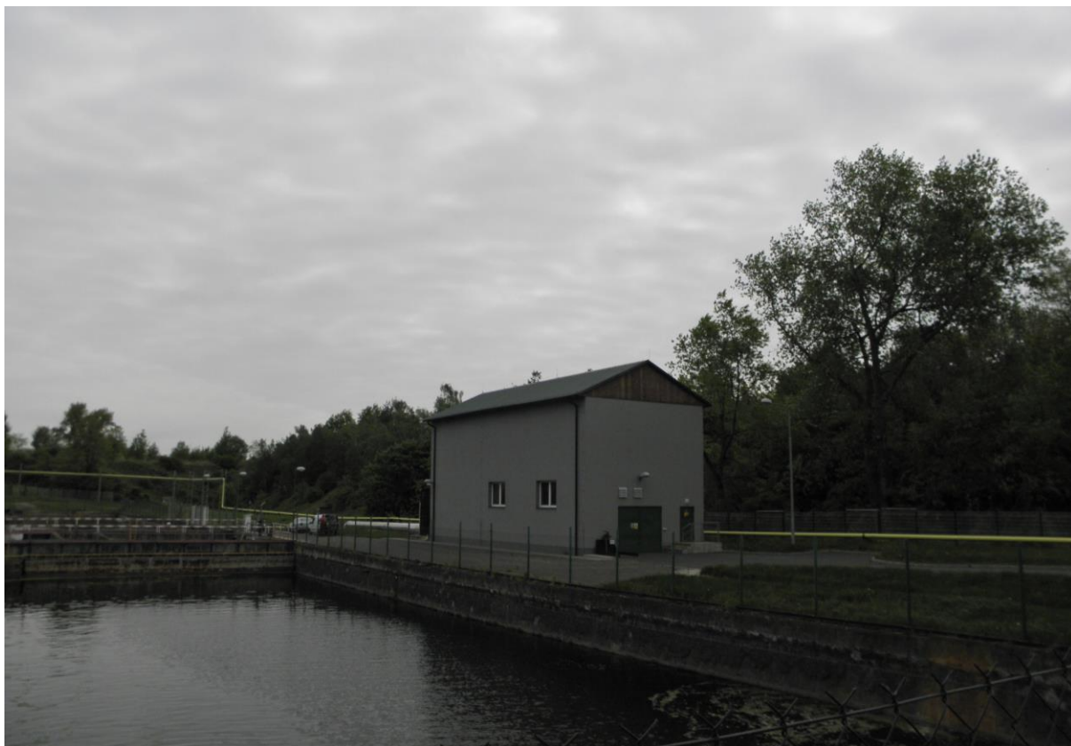
Obrázek 28: Čistírna odpadních vod
