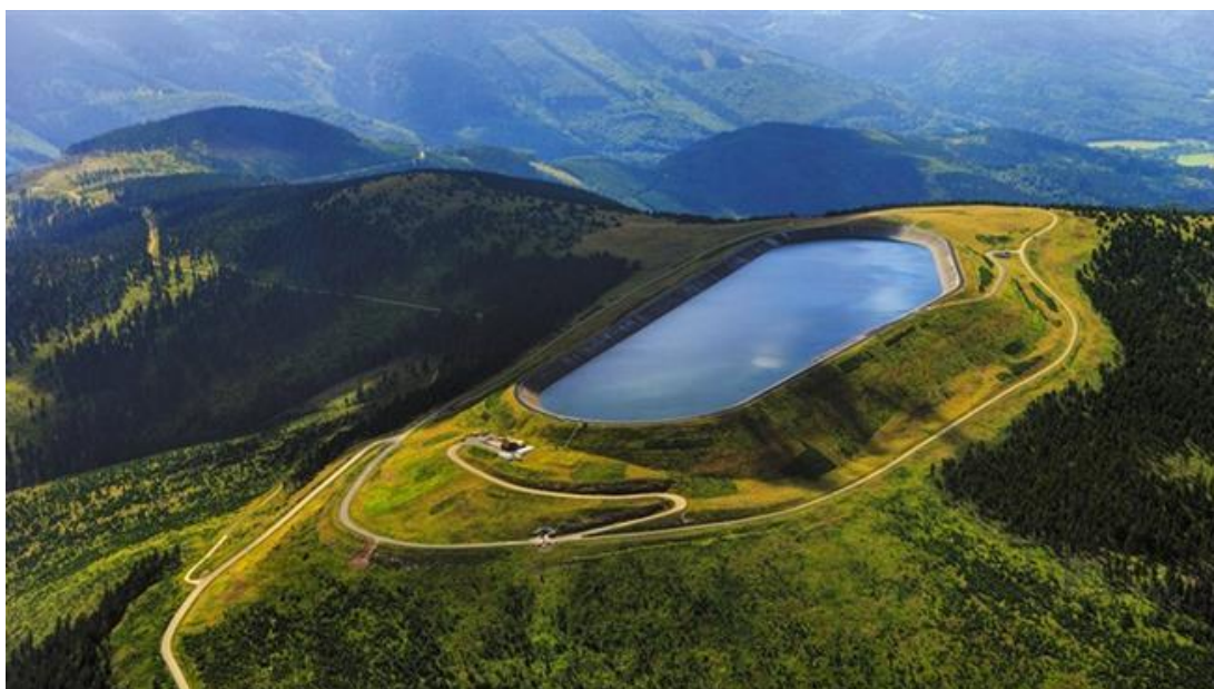
Obrázek 16: Horní nádrž přečerpávací vodní elektrárny Dlouhé Stráně
