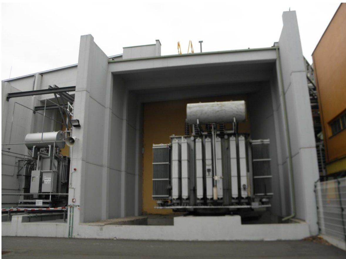
Obrázek 29: Stání transformátoru
