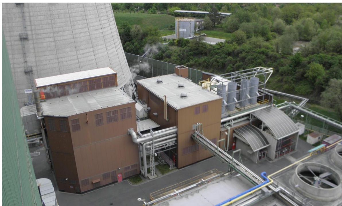
Obrázek 35: Budovy bloku K6
