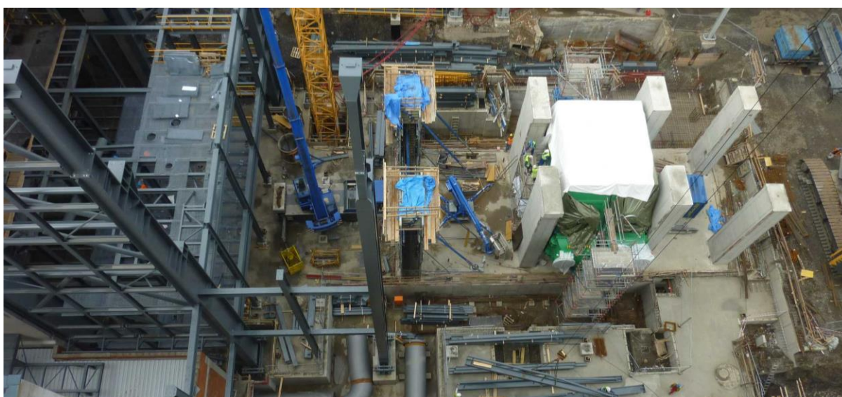
Obrázek 27: Sloupy železobetonové turbínové stolice při výstavbě
