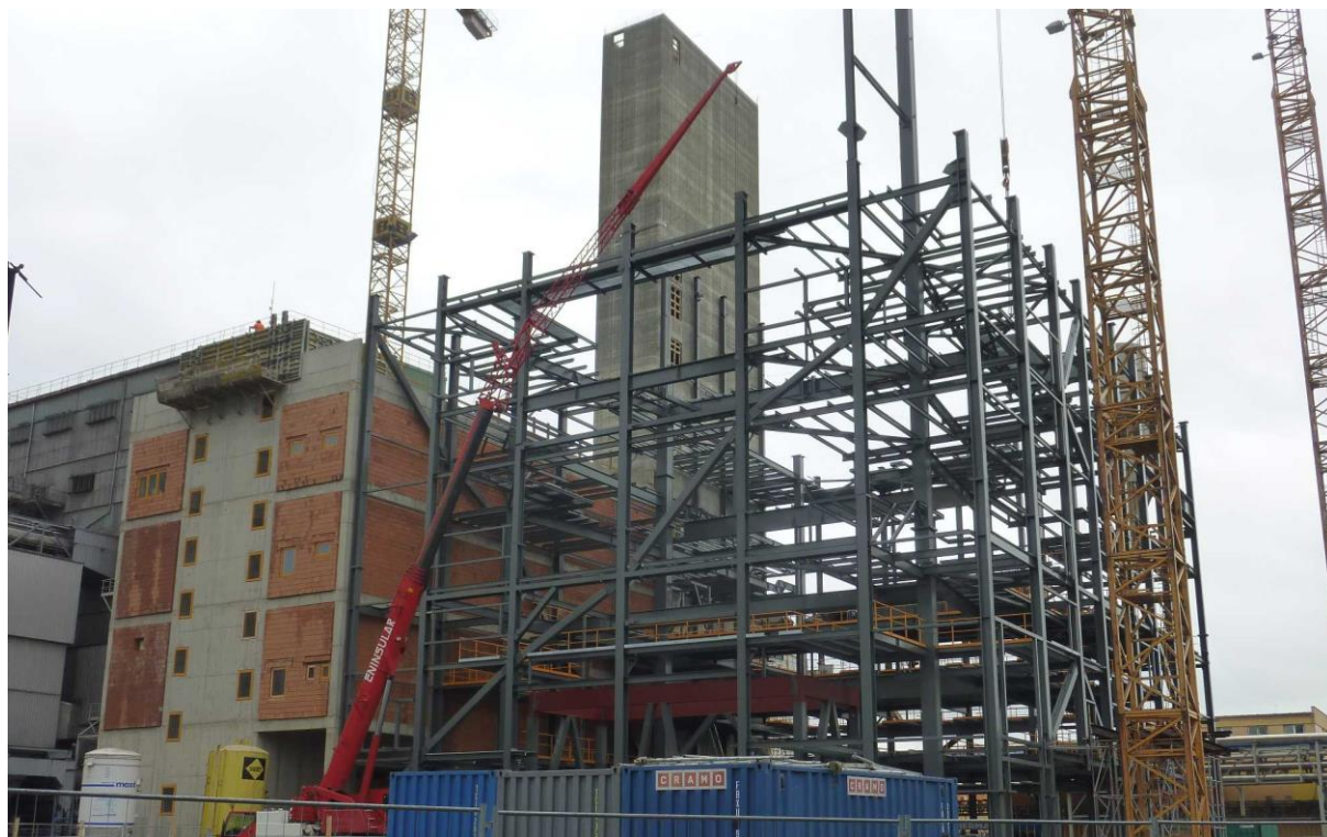
Obrázek 30: Ocelová konstrukce kotelny bloku K7
