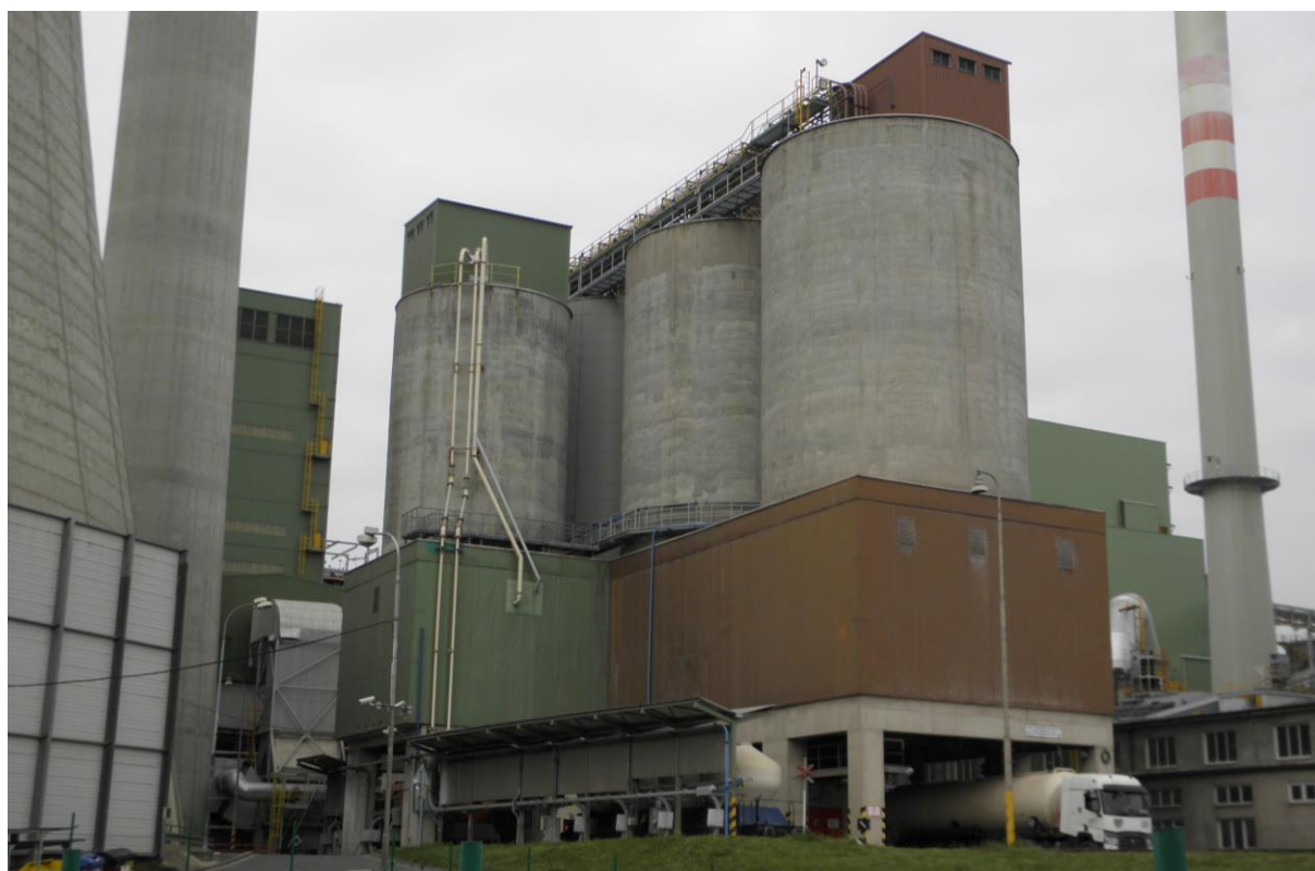
Obrázek 34: Silo na vápno (vlevo) a sila na popílek (vpravo)
