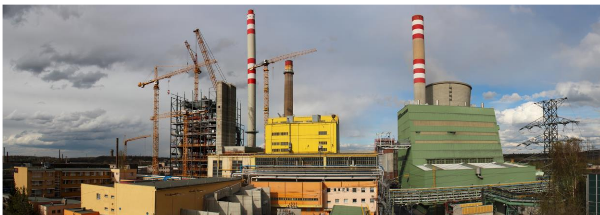
Obrázek 25: Tepelná elektrárna Kladno během výstavby bloku K7
