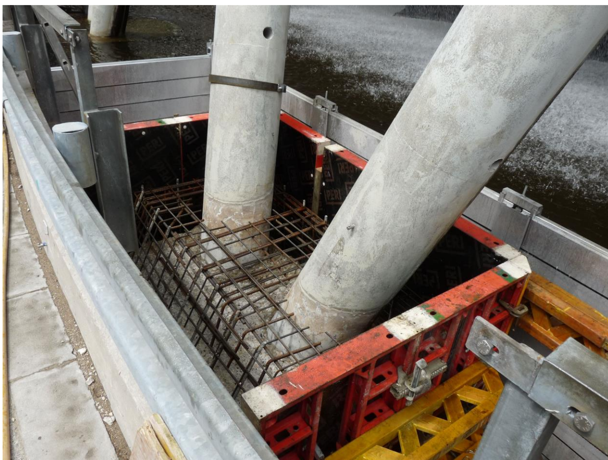
Obrázek 32: Mobilní bednění a nový armovací koš kolem základové patky chladicí věže
