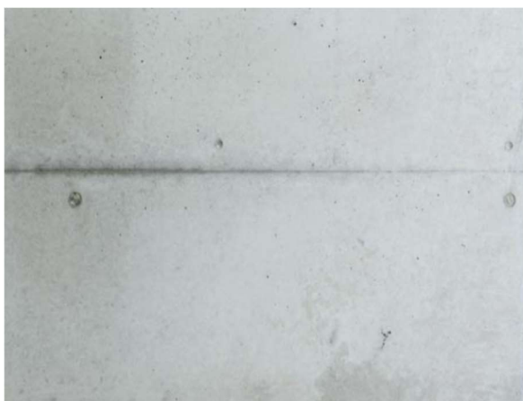
Obrázek 21 Odstín betonu – bednicí deska FinPly, zdroj: vlastní
