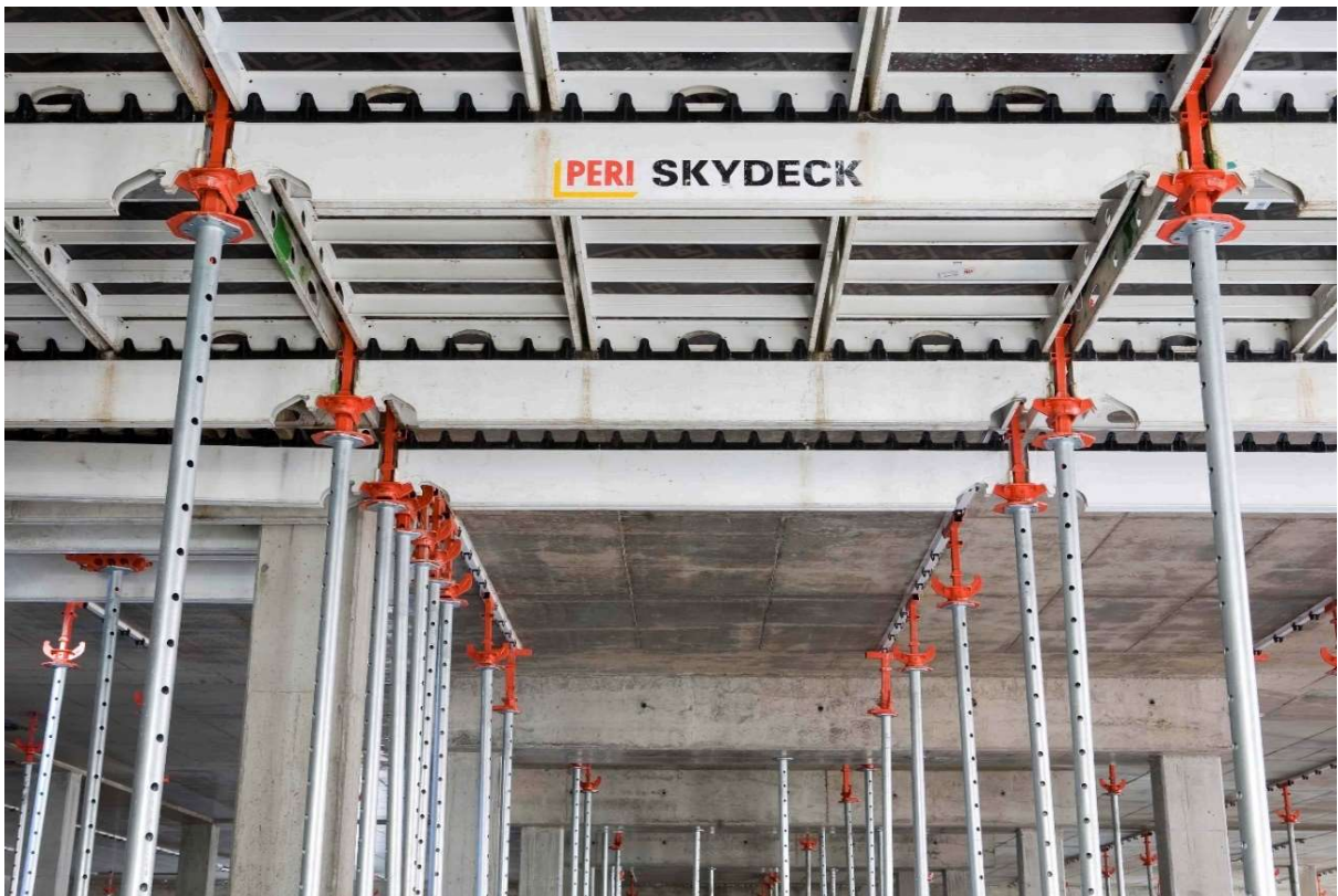
Obrázek 14 Stropní bedněň SKYDECK [9]
