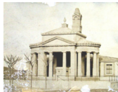
Krematorium v Miláně, 1876
