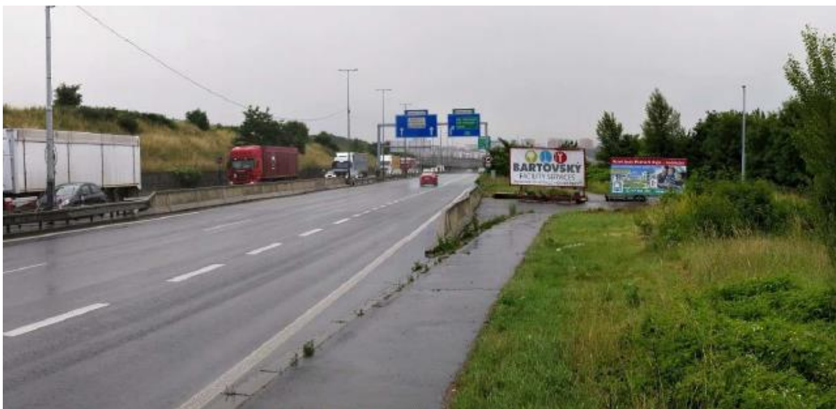
Obrázek 35 – Místo budoucí lávky přes ulici Kbelská. [19]
