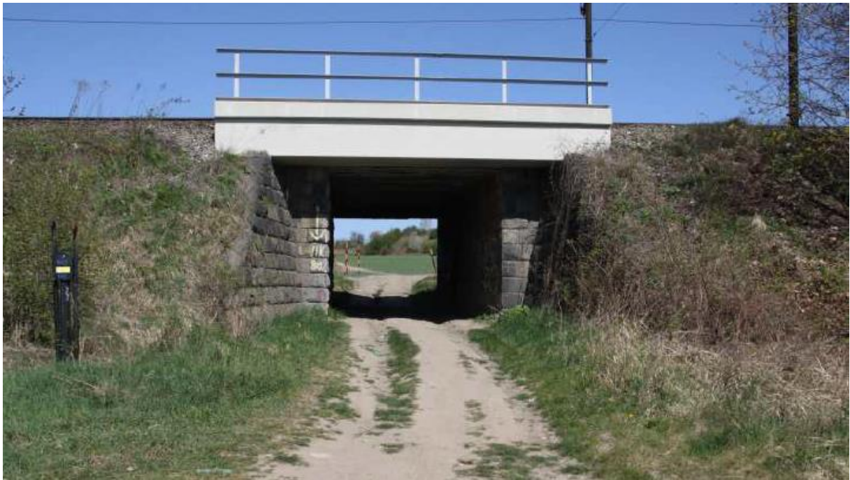
Obrázek 32 – Stávající stav budoucího křížení ul. Ocelkova s cyklomagistrálou a železniční tratí. [19]
