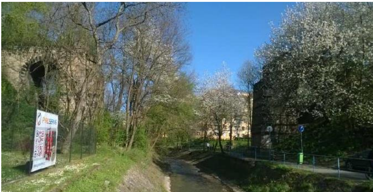
Obrázek 3 – Původní opěry mostu přes Rokytku. 60
