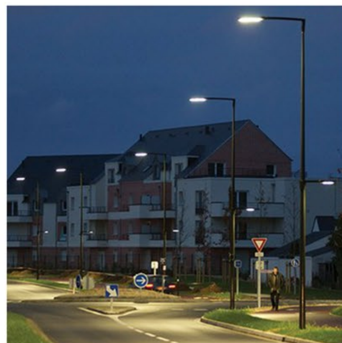
04 ULIČNÍ OSVĚTLENÍ - FIRMA: THORN - TYP SVĚTLA: StyLED - VÝŠKA: CCA 7M
