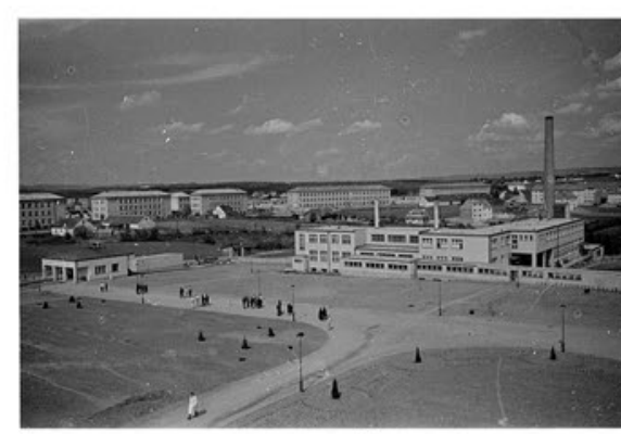
POHLED NA INTERNU A KASÁRNA Z ROKU 1939
