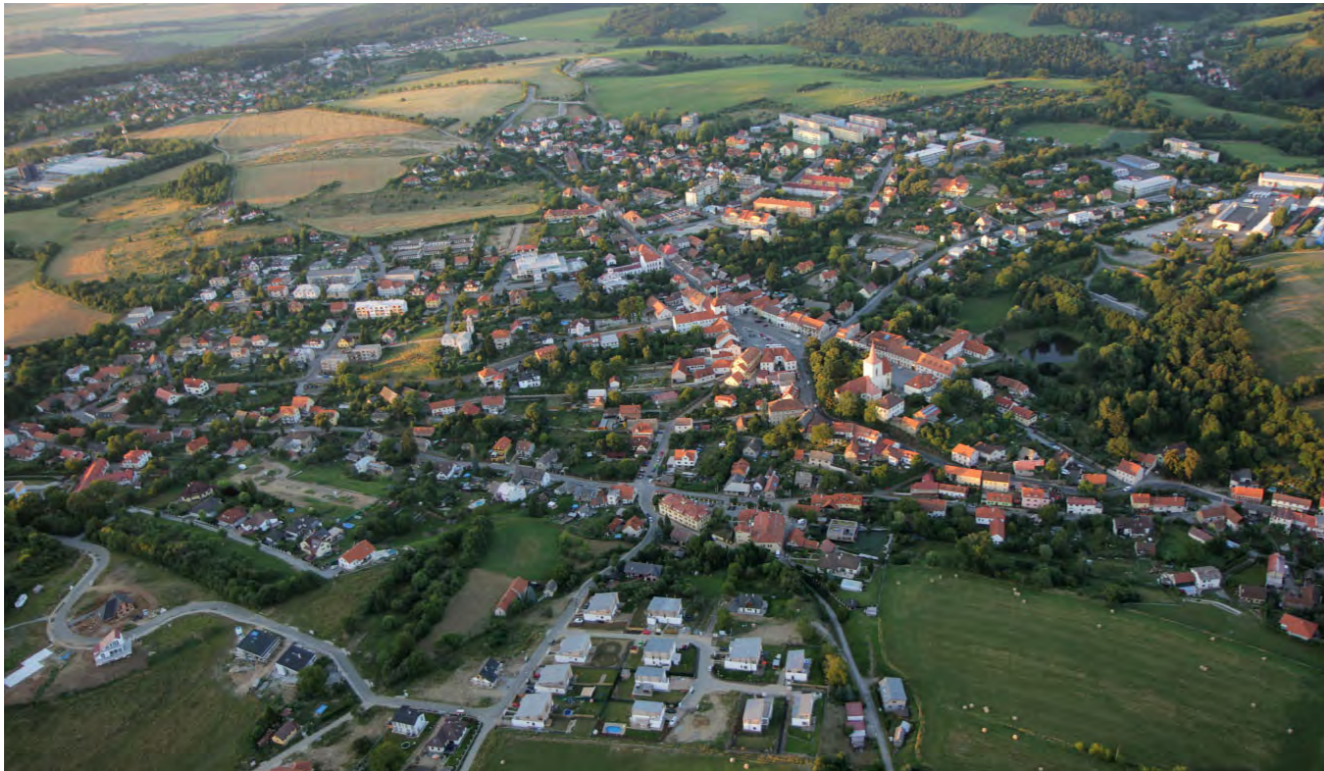
POHLED OD JIHOVÝCHODU - ROZHLEDNÝ PEPŘ
