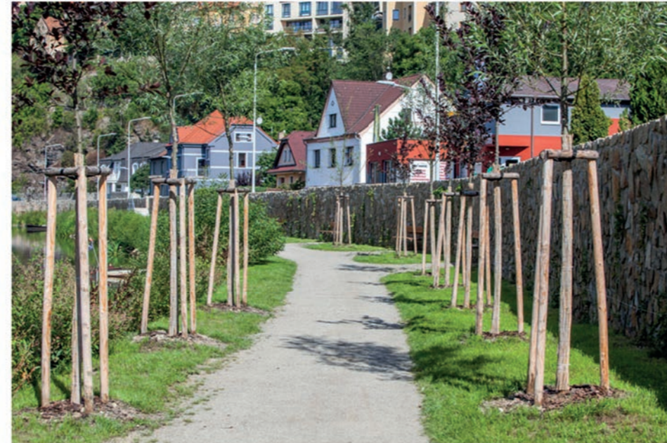
Veřejný prostor na břehu řeky Lužnice ve městě Tábor. Protipovodňová zeď (kamenná stěna) odděluje klidový prostor pro odpočinek od místní komunikace, která leží ve vyšší poloze než je cesta. Tato stěna byla využita pro umístění laviček. U zdi je vysázena řada stromů.
