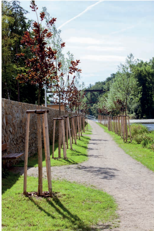
Veřejný prostor na břehu řeky Lužnice ve městě Tábor. Protipovodňová zeď (kamenná stěna) odděluje klidový prostor pro odpočinek od místní komunikace, která leží ve vyšší poloze než je cesta. Tato stěna byla využita pro umístění laviček. U zdi je vysázena řada stromů.
