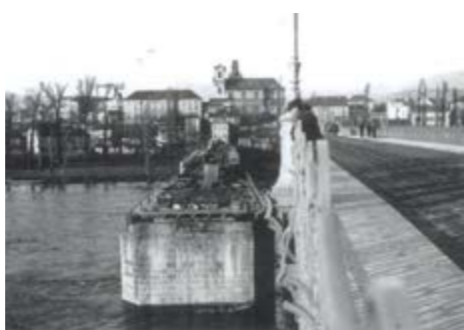
O.06 | Přestavba litoměřického mostu
