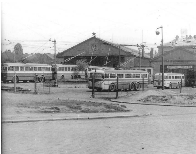
pohled na vozovnu z nároží ulic Korunní a
