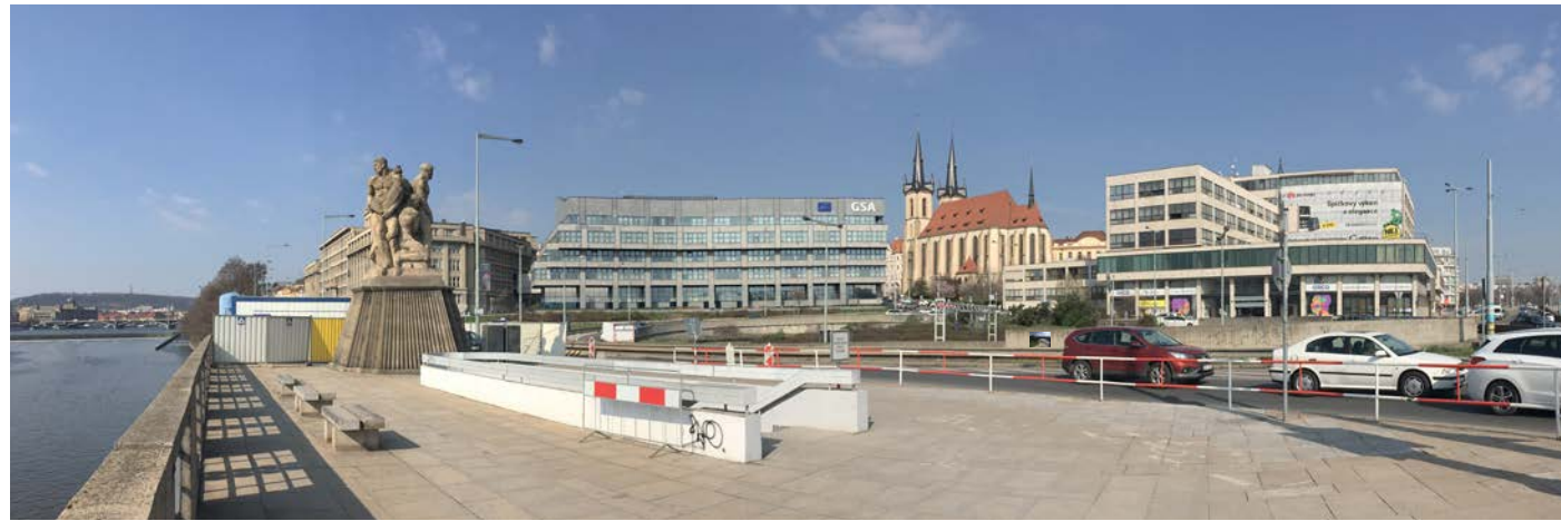
Předmostí Hlávkova mostu s vyústěním podchodu pro chodce, v pozadí kostel sv. Antonína Paduánského a budova bývalých Elektrických podniků
