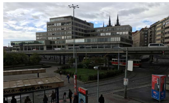
Přemostění části ulice Bubenská, pohledová bariéra
