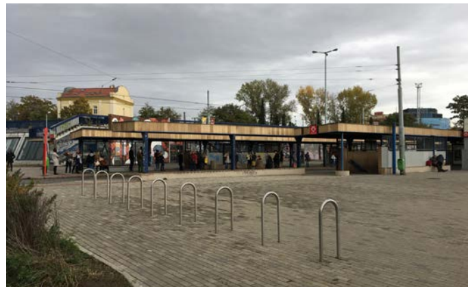
Předprostor stanice metra Vltavská, výstupy z metra, prostor pro čekání
