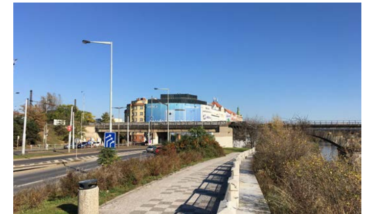
Nábřeží Kapitána Jaroše, v pozadí Negreliho viadukt
