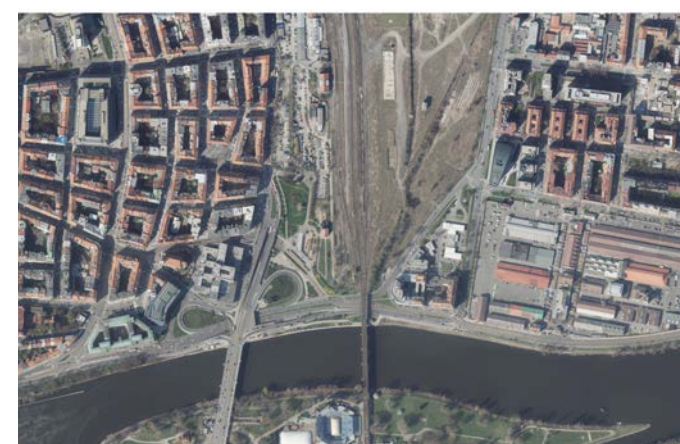
2014 - velká část nádražních budov demolována, vzniká velká volná plocha nevyužívaného kolejíště mezi ulicemi Bubenská a Argentinská 20)
