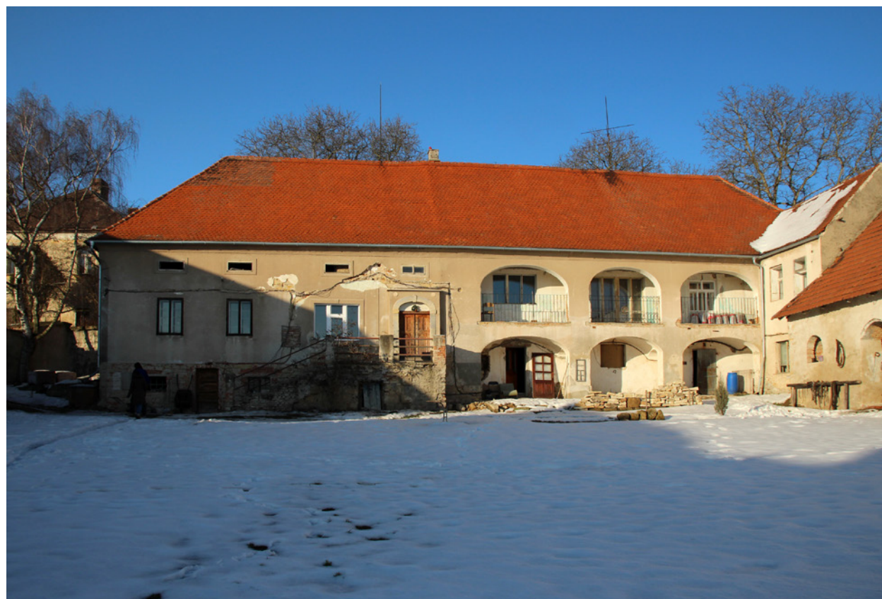
Současný stav, pohled na obytné stavení od J. Foto H. Cuřínová, 2016.
