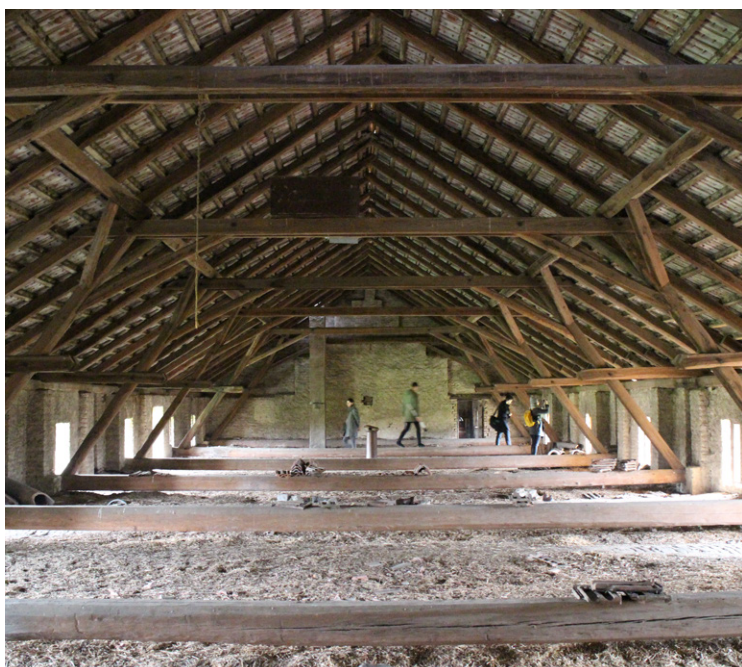
severní část podkroví hospodářského objektu
