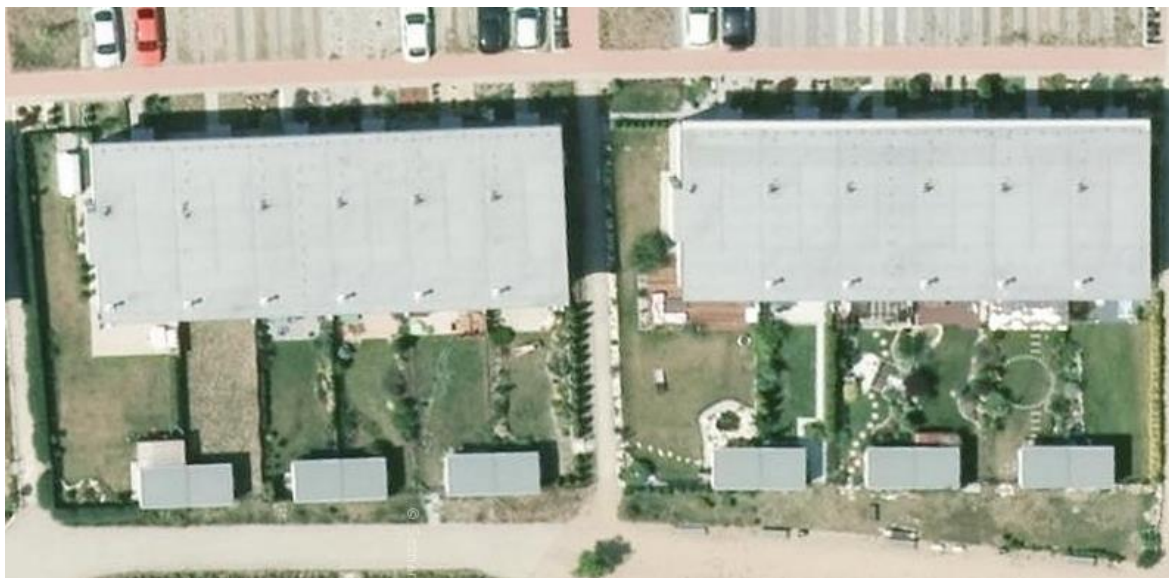
Obrázek 5-1 Řadové domky s plochou střechou jsou ideálním prostorem pro realizaci FVS
