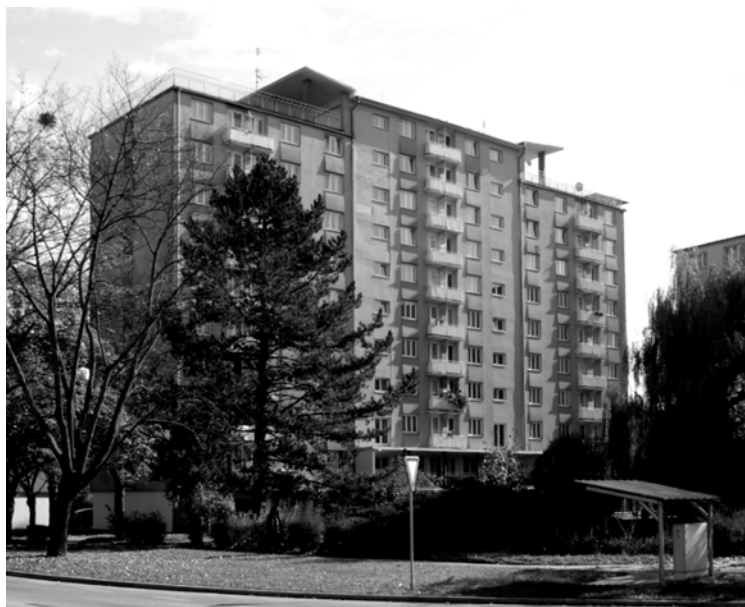
Experimentální bytový dům schodišťový - celk. pohled 2017
