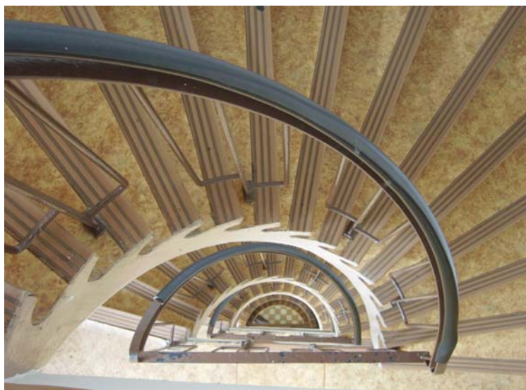
Interiér exp. bytového chodbového domu - schodiště
