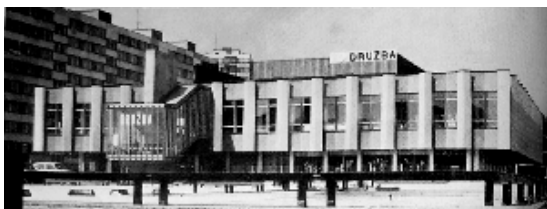
Hloušek A., Konopka L.: Centrum obchodu a služeb Družba Č. Budějovice, celkový pohled. 1974. Foto: 25 let Pozemních staveb ČB, 1976.
