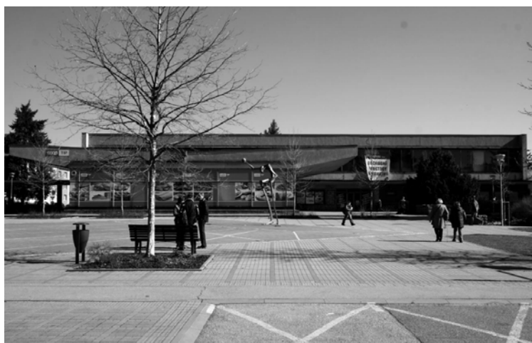
Celkový pohled od severozápadu - 2017
