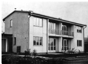
Pozemní stavby ČB: Montovaný rodinný domek z křemelinových panelů, Braník, 1959. Foto: Hlas Stavby, 1959.
