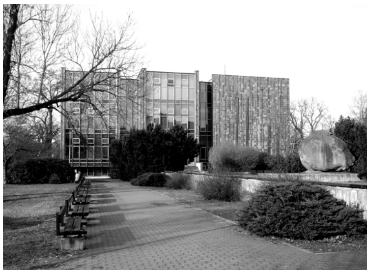
Hlavní průčelí se vchodem do budovy Autor / Zdroj: Srba J. / Archiv autora
