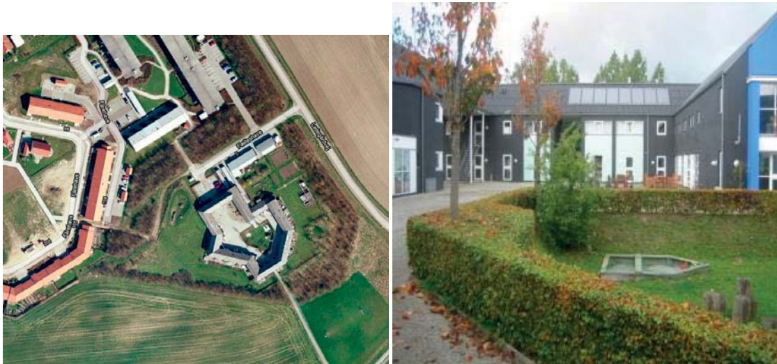
Obr. 10. 1: Vlevo: Ortofot snímek bytového souboru Fælleshave. (zdroj google/2011) Vpravo: Pohled do dvora souboru. (zdroj www komunity)
