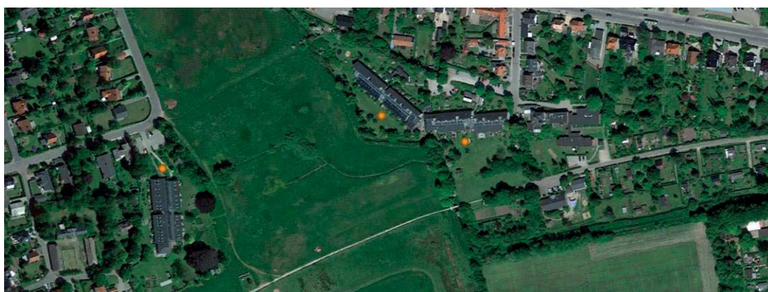
Obr. 4.70: Randers: 3 realizované soubory cohousingu jsou označeny oranžově (dokončeny 1980–1989). Vlevo Drivhuset, vpravo Ådalen 85 a Ådalen 86. Mapa: Google Earth (J. K. 2017)
