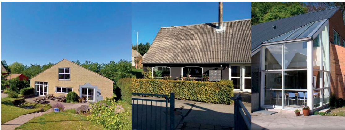
Obr. 5.29: Společné prostory komunit jsou většinou koncentrovány do jednoho místa. Vlevo: Novostavba společného domu komunity Midgården (21 domácností, 1983). Uprostřed: Komunita Møllegården (12 domácností, 1984) využila jako společný dům původní historický objekt na pozemku. Vpravo: Komunita Væksthuset (16 domácností, 1989) umístila své společné prostory na konec jednoho z objektů kolem dvora přímo vedle parkoviště. Každý, kdo do souboru vstupuje, tedy kolem nich prochází a zároveň jsou viditelné ze všech bytových jednotek. Zdroj: www.komunit
