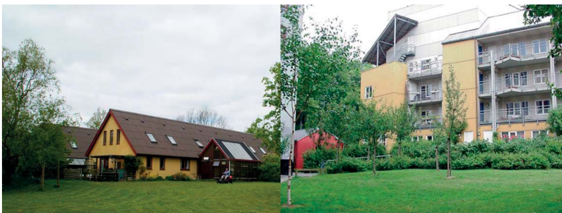
Obr. 4.23: Jednotky umístěné do domů. Vlevo: Kolbøtten (6 jednotek, 1981). Vpravo: Bo-90 (17 jednotek, 1993). Zdroj: www.komunit
