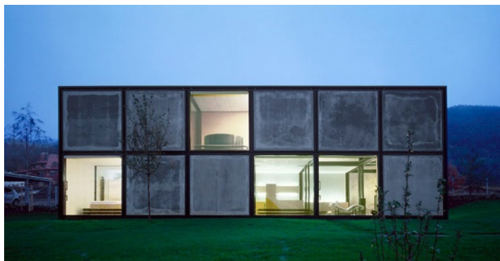
Obr. 14 HŠH architekti, Beroun (2004); foto © Ester Havlová
