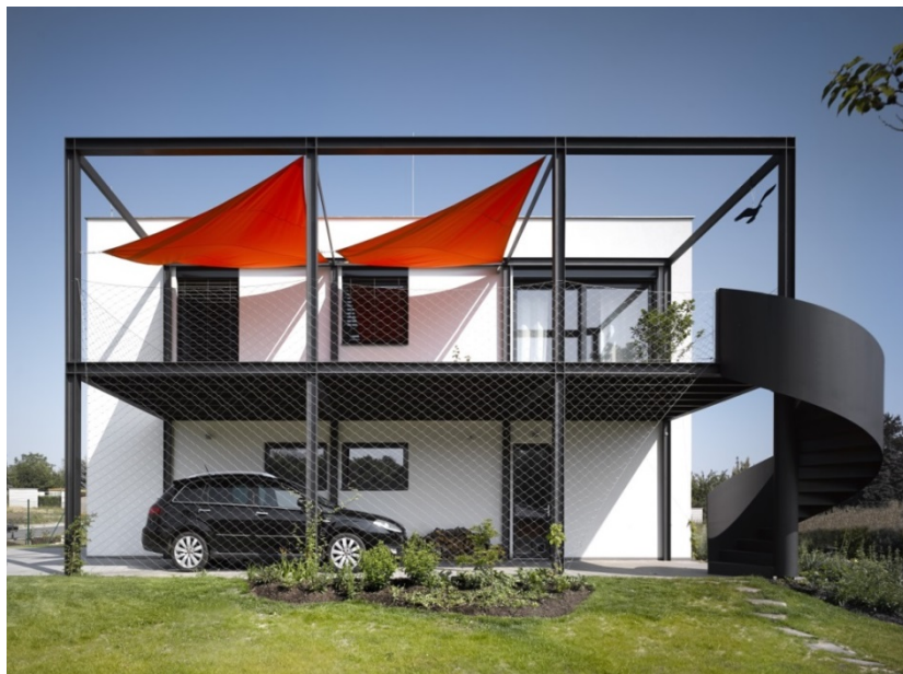
Obr. 40 Stempel & Tesař architekti, Bašt (2015); foto © Filip Šlapal
