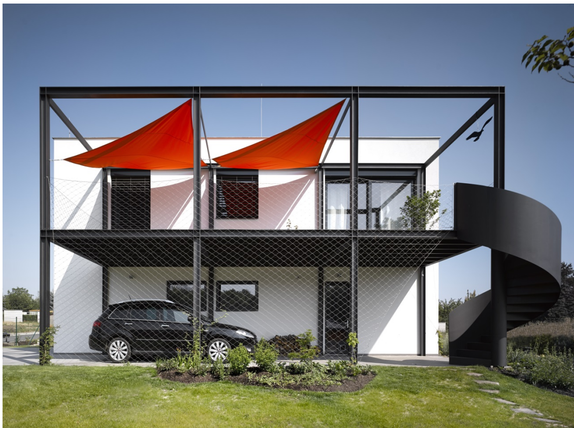
Obr. 114 Stempel & Tesař architekti, Bašt (2015); foto © Filip Šlapal
