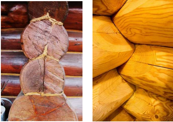
Obr. 72: Detail napojení trámů vlevo Tehov, vpravo Těptín (obojí foto Eva Bortelová)
