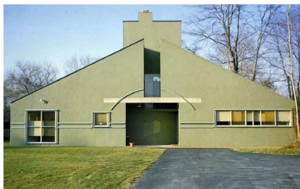
Obr. 44: Dům Vanny Venturi (foto Archdaily)
