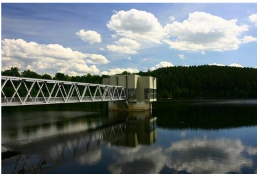
Obr. 3 Odběrový věžový objekt. Zdroj: www.foto.mapy.cz
