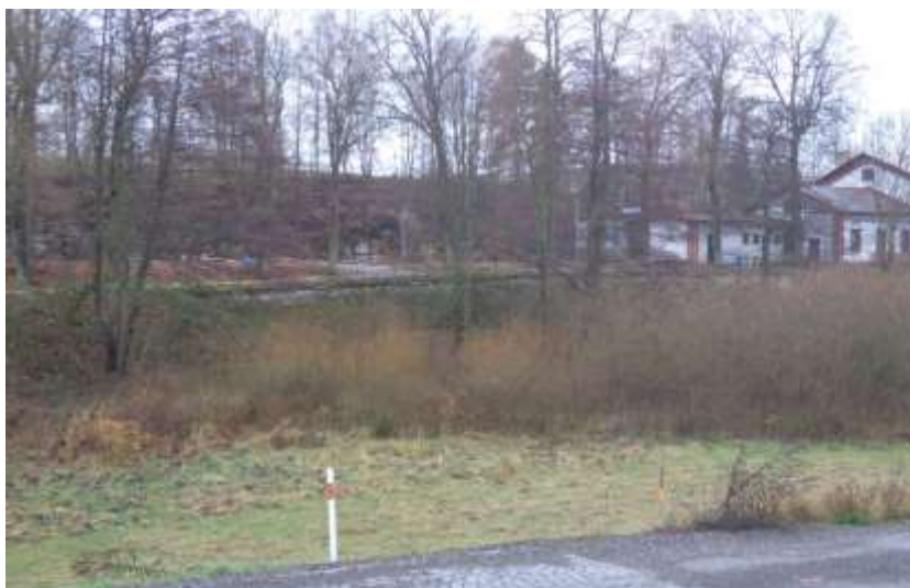
Obrázek 22: Opěrná zeď v železniční stanici Teplice nad Metují [autor]
