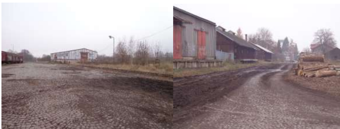
Obrázek 10: Železniční stanice pro nakládku dříví na žel. vagón v Broumově [autor]
