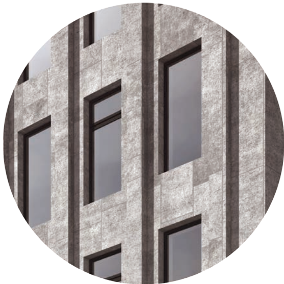
keramická fasáda s provětrávanou mezerou
