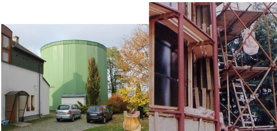
Obrázek 15: Vlevo hotový zásobník. Vpravo konstrukce pláště zásobníku. Tepelnou izolaci tvoří tuhé desky z minerální vlny, vkládané do připraveného rámu. Zásobník je celý opláštěn trapézovým plechem. Samotná konstrukce z oceli, montovaná na místě. [Archiv O. Mareš; [12]]
