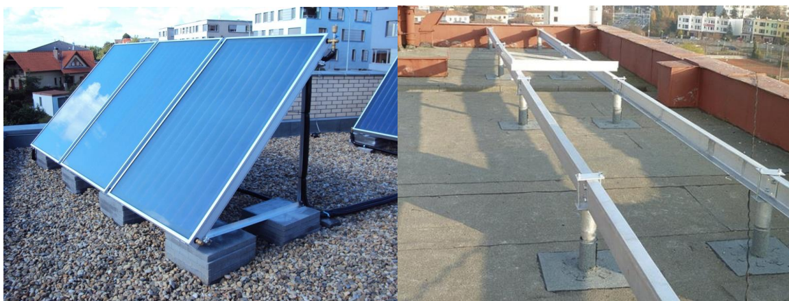
Obrázek 26: Vlevo zátěžová nosná konstrukce solárních kolektorů. Vpravo Kotvená nosná konstrukce solárních kolektorů. [22]
