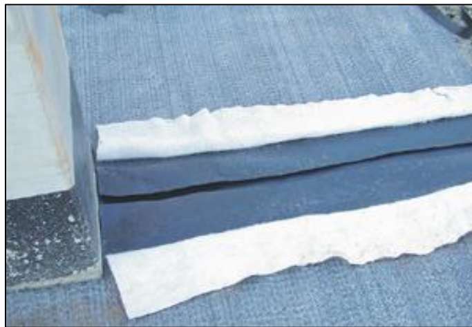
Obr. 5 – Bentonitová rohož (Lineko s.r.o.)
