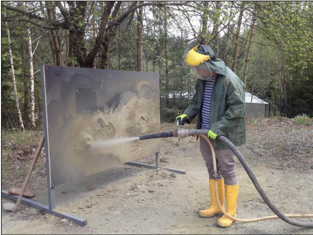
Obr. 9 - Test nástřiku bentonitu suchou technologií
