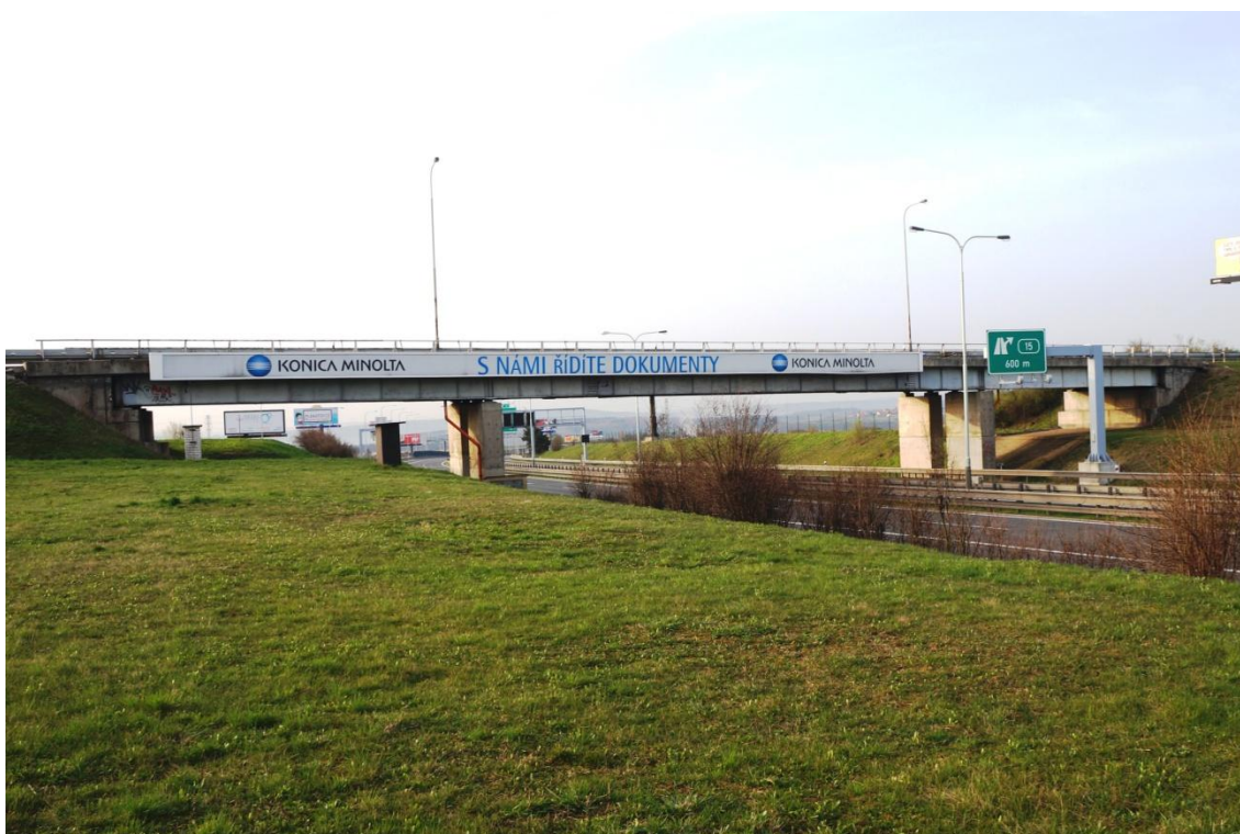
Obr. 3.5 Pohled na most od severu
