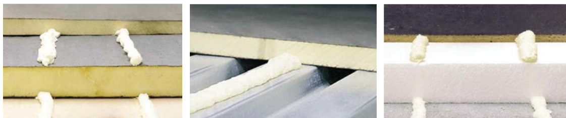
Obrázek č. 7, Aplikace PU lepidla ve střešním souvrství, zdroj: www.honter.cz
