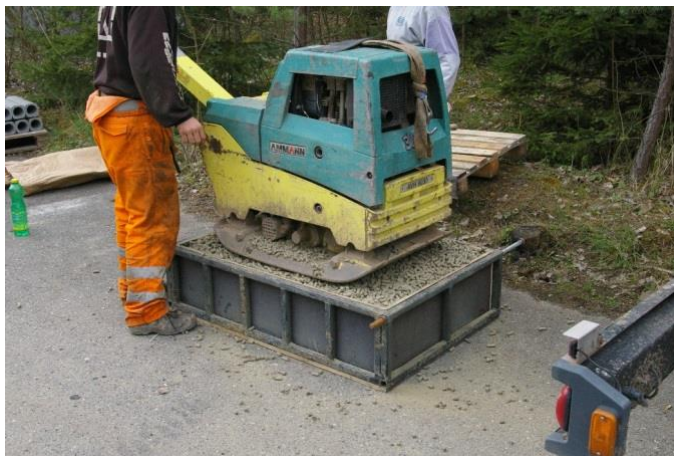
Obr. 36 – Experimentální drcení B75 PEL 12 s cílem úpravy zrnitosti.
