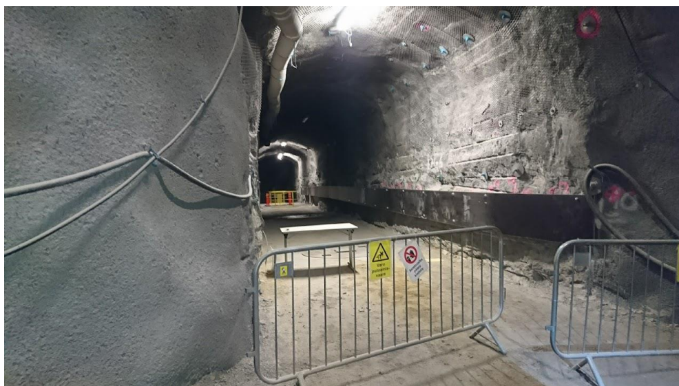
Obr. 1 – Obrázek z prvního úložiště pro vyhořelé jaderné palivo a další vysoceaktivní radioaktivní odpady ve Finsku – Olkiluoto; pohled do rozrážky pro testování technologií pro ukládání; foto autor 2017.
