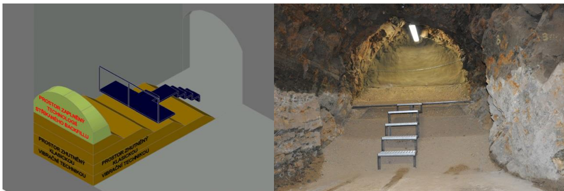
Obrázek 2 – Návrh zaplnění jedné z rozrážek štoly Josef a foto po realizaci modelu
