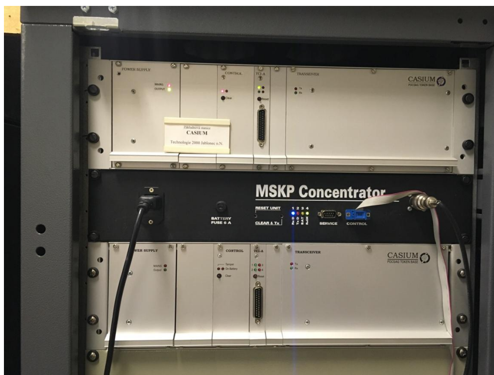
Obr. 42 – Vysílací stanice JSVV doplněna o PSD MSKP. [100 LB]
