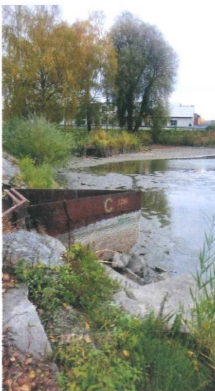
Kontrola technického stavu hlásného profilu kategorie „C“ v obci Veřtuby
