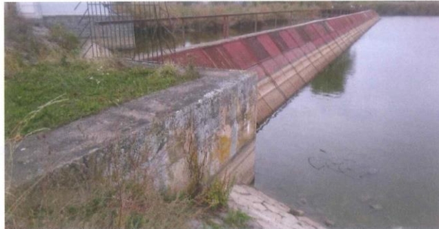
Kontrola technického stavu hlásného profilu kategorie „C“ v obci Žehuř
