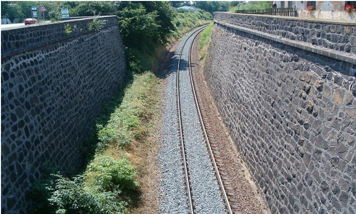
Obrázek č. 5: železniční úvoz
