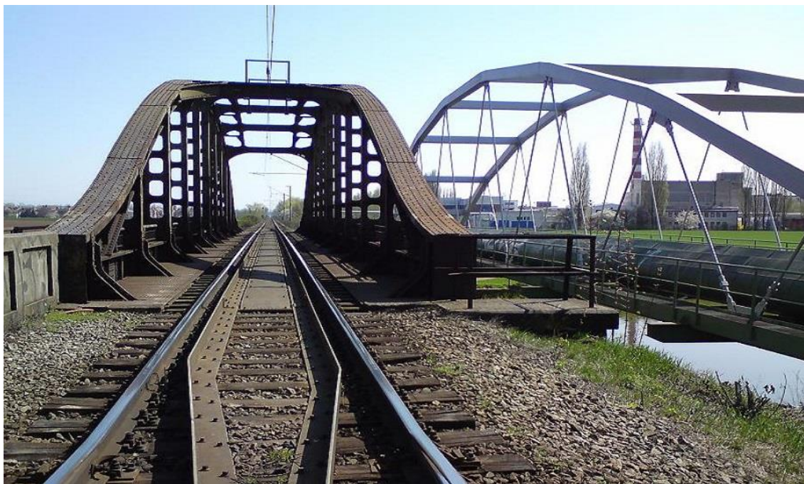
Obrázek č. 4: železniční most
