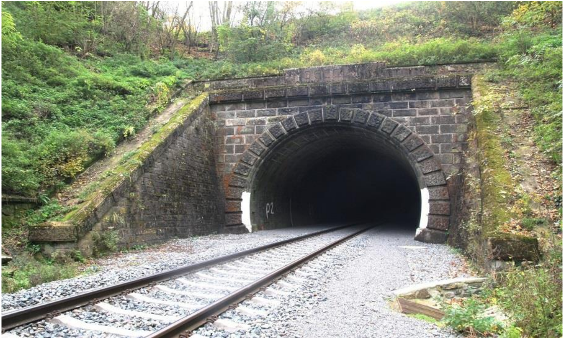
Obrázek č. 1 - železniční tunel
