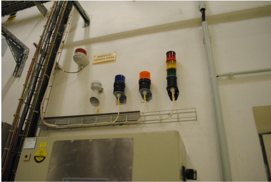
Obrázek 7 - Výstražná světla detekčního systému. Foceno během odstávky, proto nesvíí zelené světlo (zdro: Autor)
