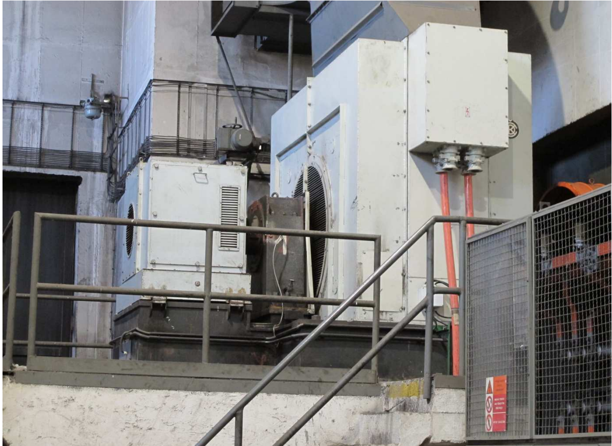
Obrázek 17 - Synchronní motor 3,25 MW s budičem typu RBL
