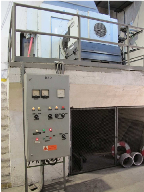
HDV důl ČSM Jih, 3B 325-12H, v.č. 127 267, 3,2 MW. Náhrada technologického rozváděče
