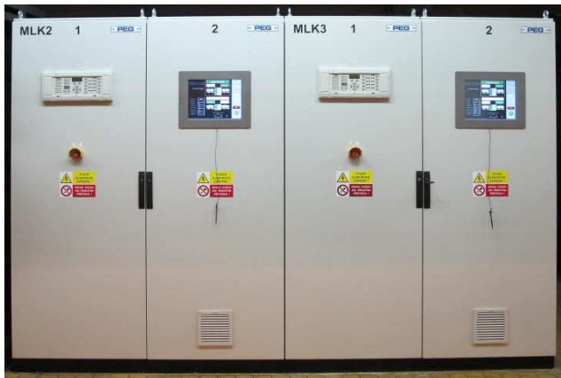
OKD, a.s., důl ČSA, budiče PEG 400/μP7, s implementovaným technologickým regulátorem rotačních kompenzátorů 3x 5 Mvar.
