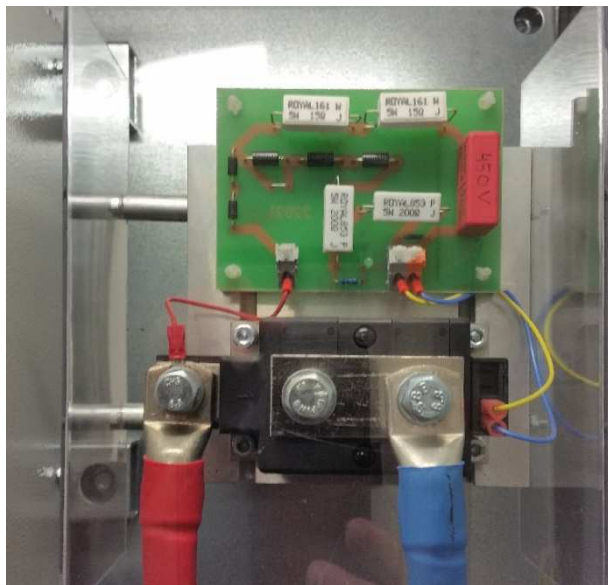
Obrázek 41 - PEG POSM ve stacionárním budiči PEG 360/ \mu P7, synchronní pohon boxerkompresoru PZP Tvrdonice
