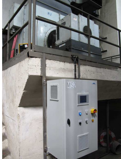
HDV důl ČSM Jih, 3B 325-12H, v.č. 127 267, 3,2 MW. Náhrada technologického rozváděče
