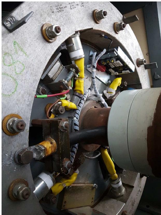
Obrázek 42 - Náhrada Přepět'ové ochrany UZP 211 v rotačním budiči RBL
