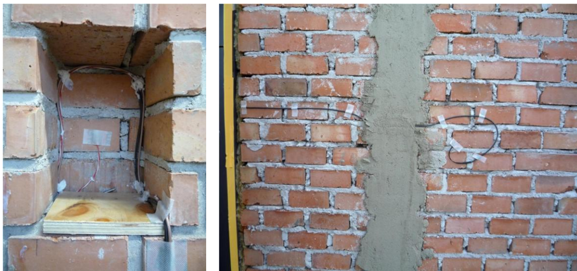
obr. 93 – Pohled do prázdné trámové kapsy (vlevo) a na neomítnuté zdivo testovacího pole ze strany exteriéru (vpravo), zdroj [15]
