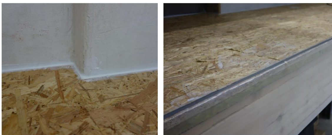
obr. 94 – Utěsnění stropní konstrukce v rámci experimentu na UCEEBu, zdroj [15]
