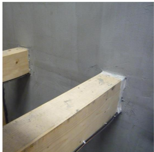
obr. 27 – Systém zateplení vakuovými deskami Va-Q-VIP F-EPS (skladba S3), zdroj [15]
