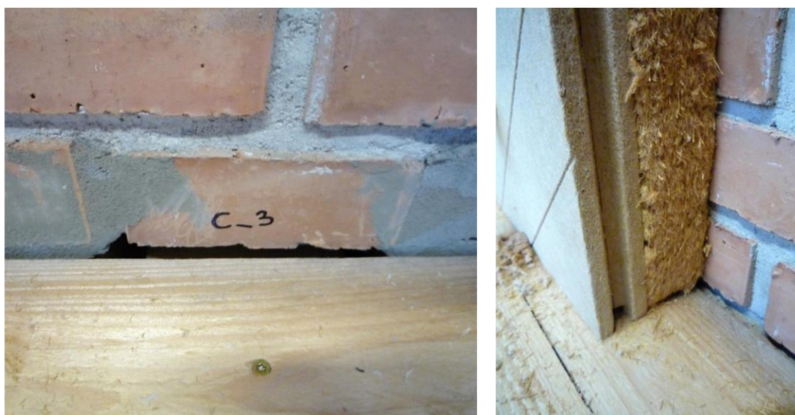
obr. 97 – Strop bez zásahu – situace u trémových kapes (vlevo), aplikace zateplovacího systému Ciur 80 mm (vpravo), zdroj [15]
