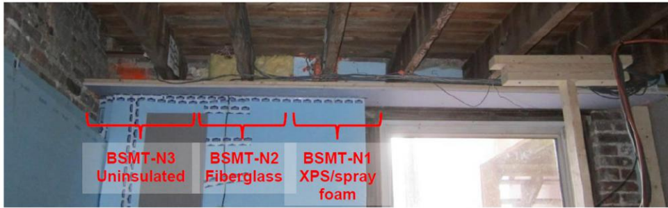
obr. 16 – Situace u trámových zhlaví v suterénu [12]
