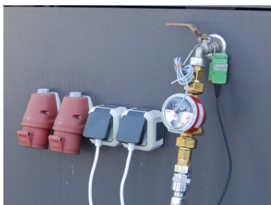
obr. 74 – Osazení vodoměru s impulzním výstupem na přívodu vody (vlevo), opatření pro zachycení odtékající vody z testovacího pole (vpravo)
