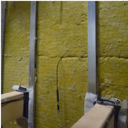
obr. 26 - Systém zateplení deskami z minerální vlny Isover AKU + „inteligentní“ fóliová parozábrana (skladba S2), zdroj [15]
