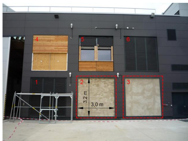
obr. 24 - Poloha experimentální fasády UCEEB, vyznačení dvou testovacích polí vyhrazených pro experiment, zdroj [15]
