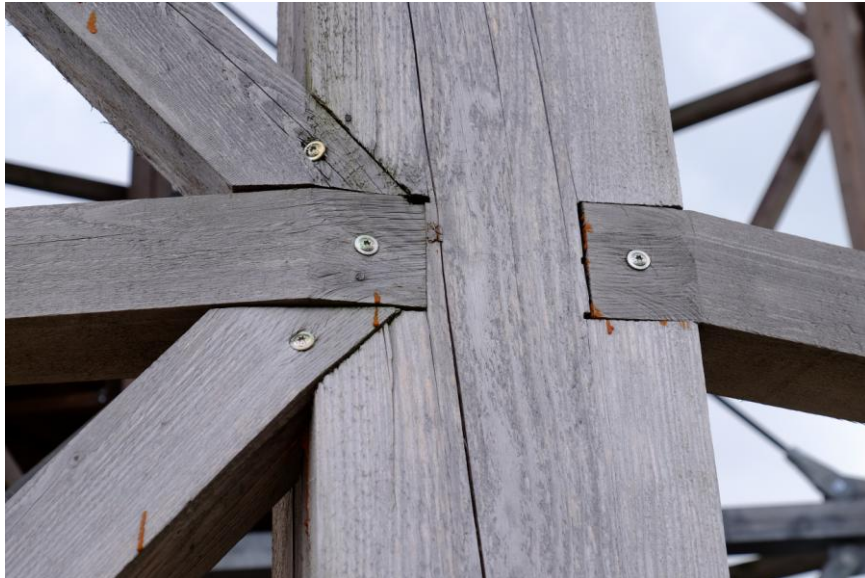
Obrázek 31: Uchycení pláště rozhledny
