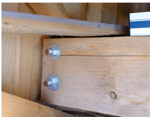
Obrázek 6: Nedodržení osových vzdáleností spojovacích prvků
