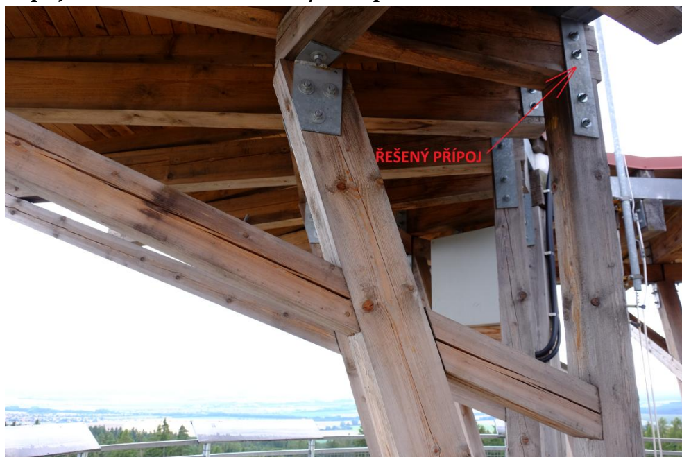
Obrázek 56: Lokalizace přípoje střešní nosník / sloup
