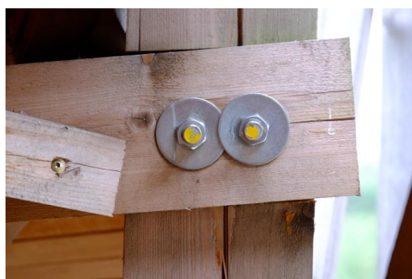
Obrázek 5: Nedodržení osových vzdáleností spojovacích prvků
