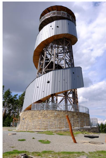
Obrázek 1: Foto stávajícího stavu
