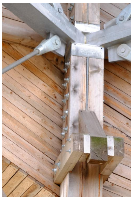
Obrázek 3: „čtyřstržný“ deformovaný spoj
