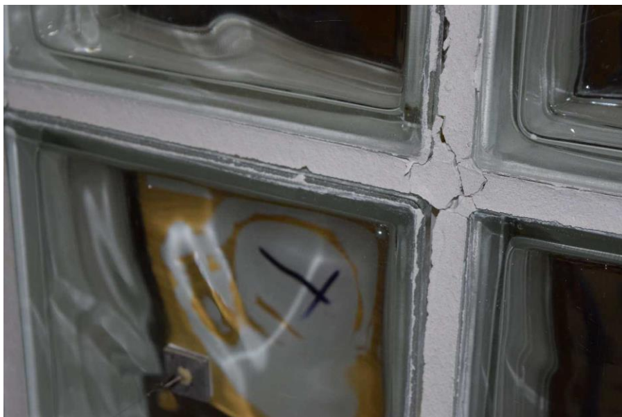
Obr. 83 Protlačování tvárnice
