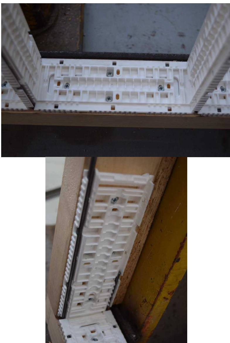
Obr. 68 Kotvení krajních rámečků k dřevěnému rámu
