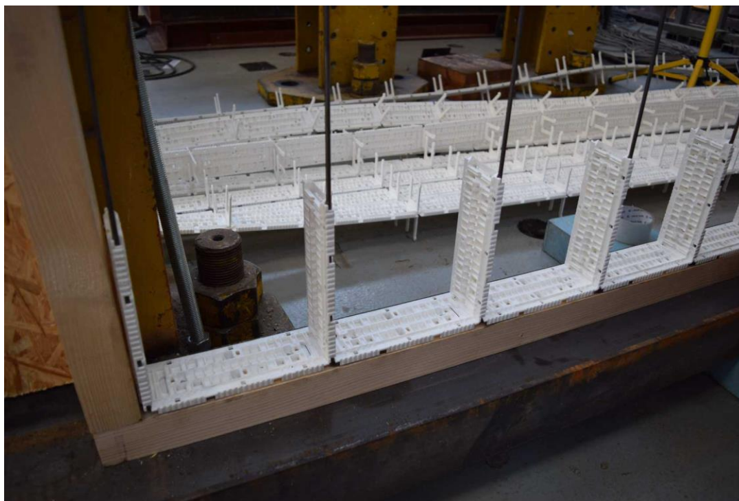
Obr. 69 První řada připravená na osazení tvárnic
