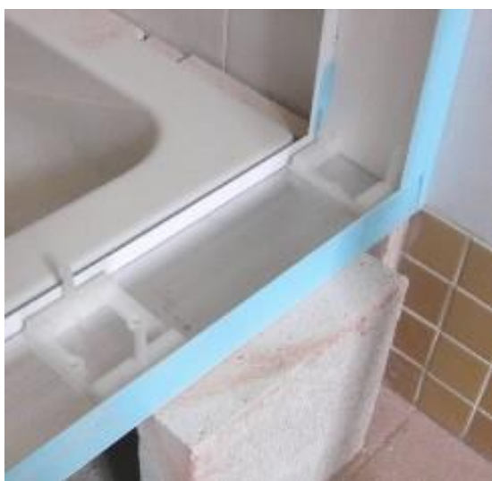
Obr. 28 Založení první řady [4]
