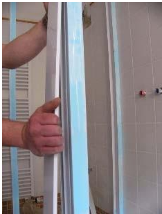
Obr. 27 Fixace zakončovací lišty [4]
