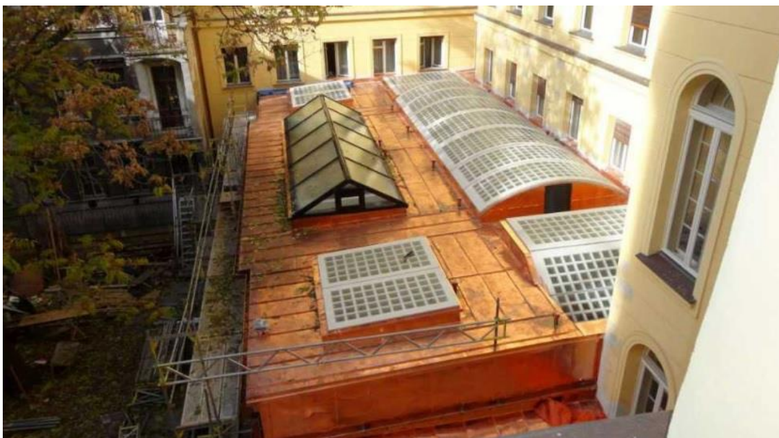
Obr. 2 Rekonstrukce střechy Praha
