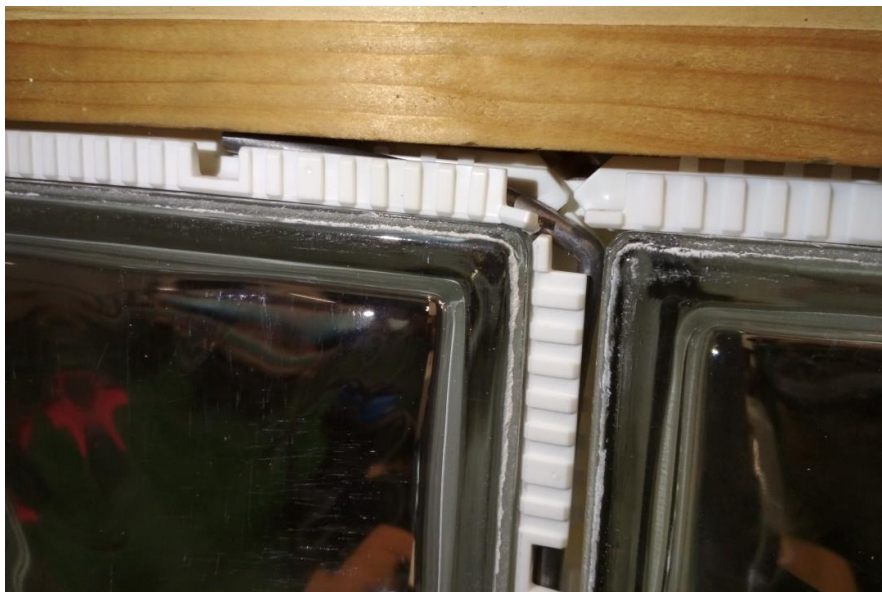
Obr. 63 Opření výztuže o dřevěný trámek
