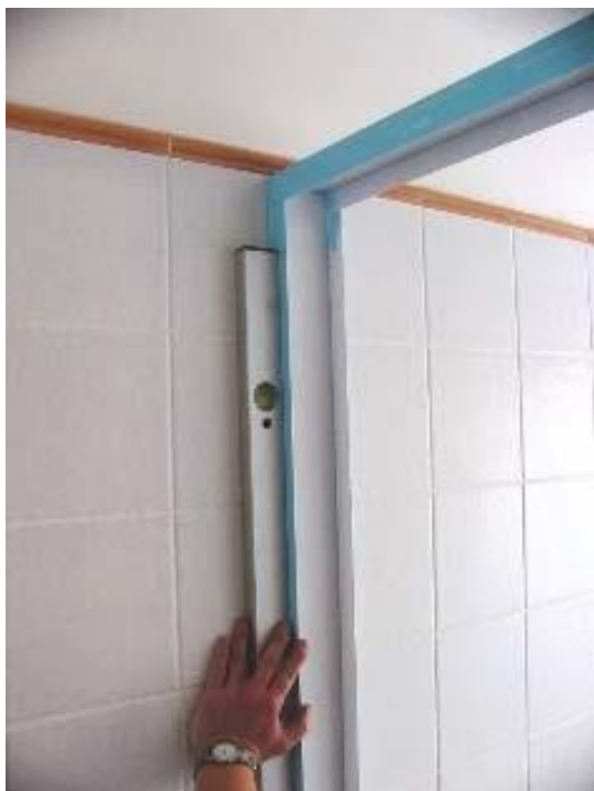
Obr. 26 Vyrovnání rámu do stavebního otvoru [4]
