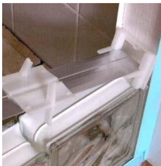
Obr. 29 Vymežovací profil s křížky [4]
