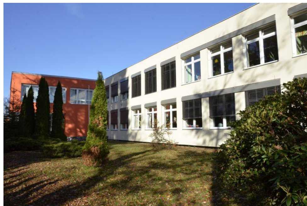
Obrázek 63 – Zateplená fasáda ZŠ Liberecká (Autor: MMJN, Zdroj: http://www.mestojablonec.cz )
