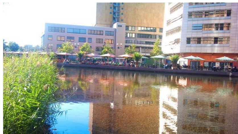
Obrázek 51 – Umělé jezero na dešťovou vodu zásobované dešťovým odtokem ze střech na Potsdamer Platz v Berlíně (Zdroj: http://www.phasenwechsel.com/Bilder/potsdamer%20platz03.jpg )
