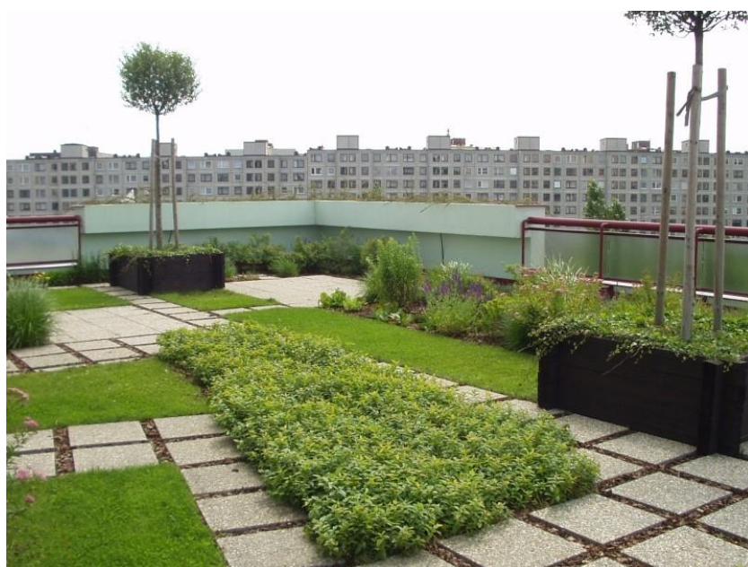
Obrázek 49 – Extenzivní zelená střecha (Zdroj: http://zelenestrechy.cz )
