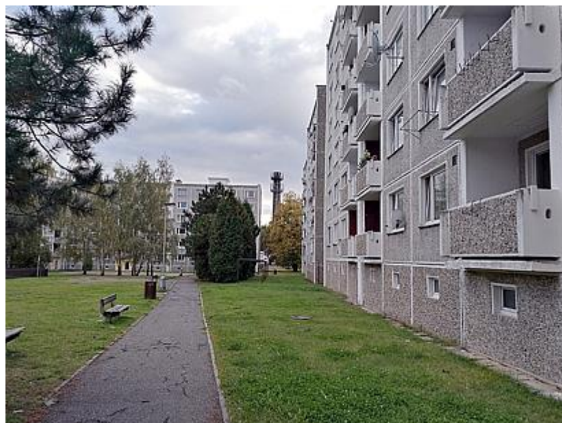
Foto 44 Jihozápadní pohled po cestě vedoucí v horní části vnitrobloku spodního sídliště. V pozadí je vidět průhled na komín.
