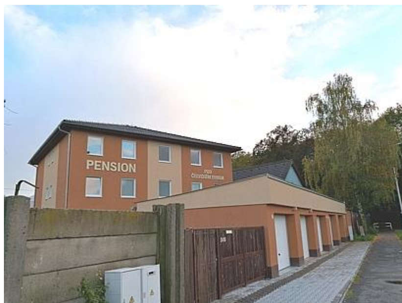
Foto 63 Jihozápadní pohled na budovu pensionu Pod červeným bukem s přílehlými garážemi. V pozadí za penzionem je k povšimnutí střecha budovy restaurace patřící též k penzionu.
