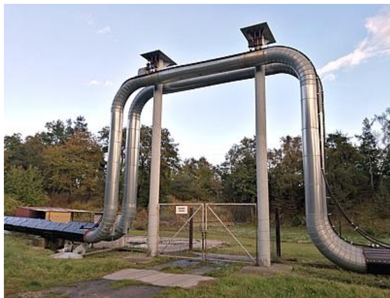
Foto 23 Detail zpřístupnění soukromého pozemku pod sídlištěm vyvýšením vedení teplovodu.
