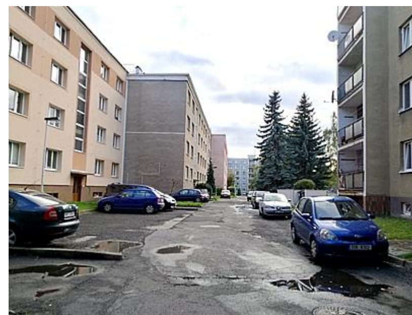
Foto 30 Pohled z východního konce jižní strany vnitrobloku. Na snímku je více patrné odskočení jednotlivých bytových domů a parkovací místa před budovami.
