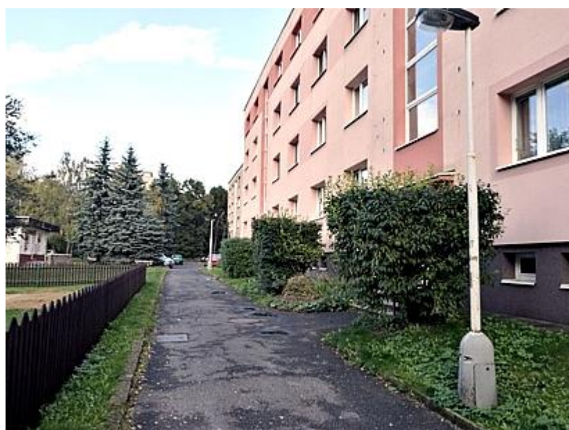
Foto 27 Pohled podél jižní strany vnitrobloku. Vzadu po levé straně snímku můžeme vidět drobný obchůdek s potravinami.
