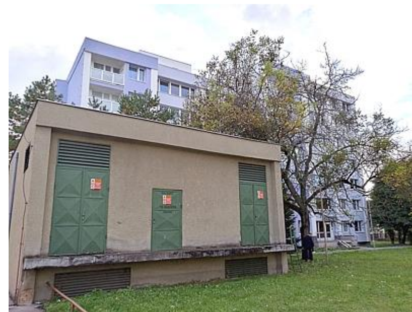
Foto 52 Jihozápadní pohled na trafostanici, nacházející se ve střední části sídliště, při procházení místní komunikací.
