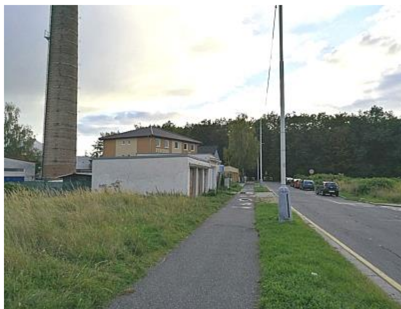
Foto 60 Jihozápadní pohled komunikací nad areálem bývalého dolu Engerth. Tato část komunikace je obousměrná.
