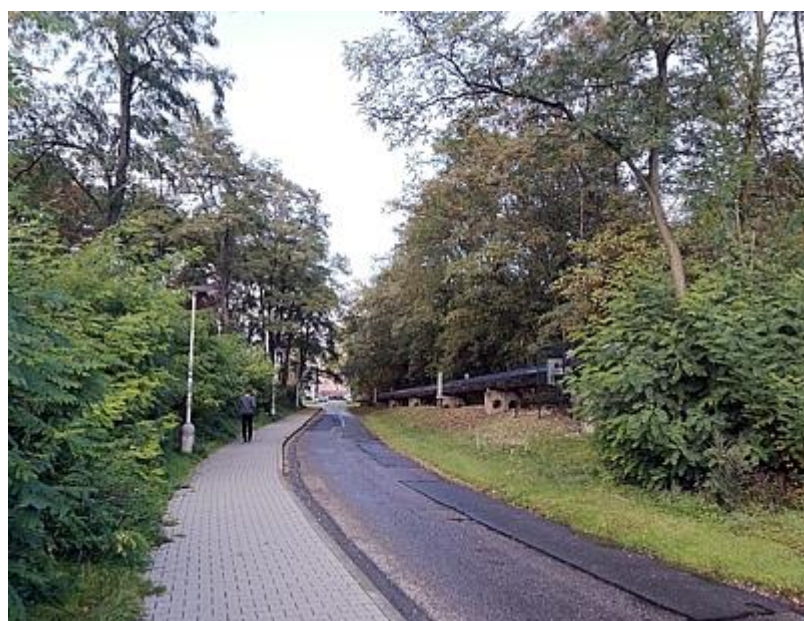
Foto 17 Pohled jednosměrnou komunikací v ulici U Engerthu, vedoucí podél východní hranice řešeného území. Tato komunikace slouží jako jediná vstupní komunikace pro oblast sídliště a navazující obytné zóny. Vlevo od komunikace na snímku se nachází část řešené haldy.
