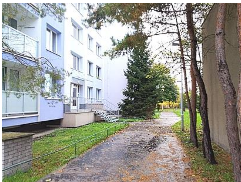
Foto 51 Pohled na přístupové cesty k bytovému domu v severní části sídliště. Na pravé straně se můžeme povšimnout budovy elektrické stanice rozvodné sítě, viz další fotografie.
