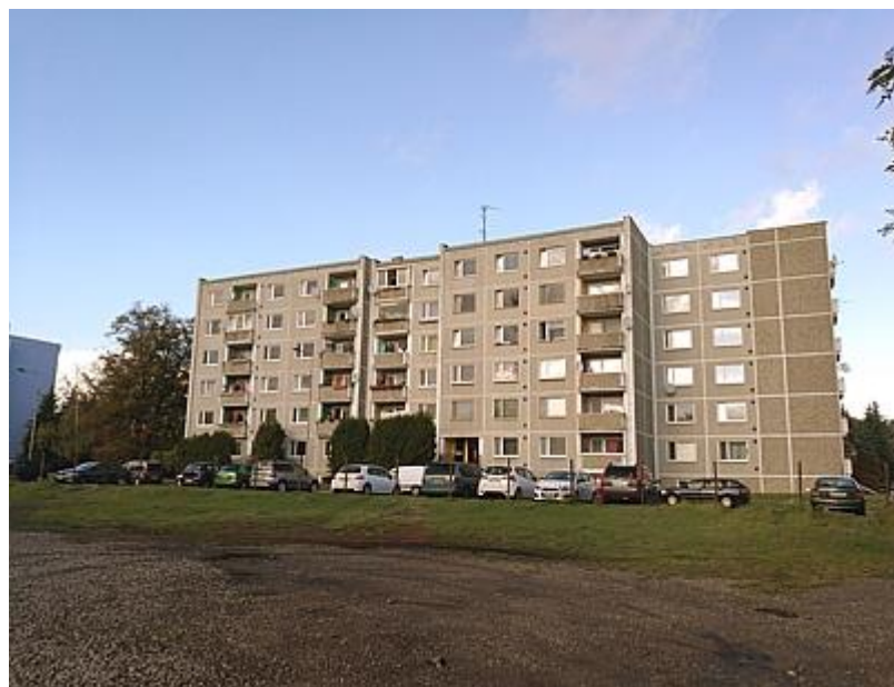
Foto 11 Severovýchodní pohled na spodní blok sídliště od bývalé těžní budovy. V přední části se můžeme povšimnout pásu kolmého parkování podél procházející místní komunikace.
