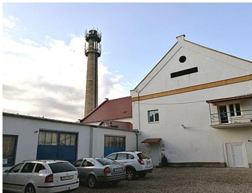
Foto 10 Severozápadní pohled na bývalou těžní budovu. V levé části je vidět nová přístavba, v pravé části původní těžní budova snižená o dvě patra. Ve středu snímku tvoří jasnou dominantu komín, využívaný jako vysílač.
