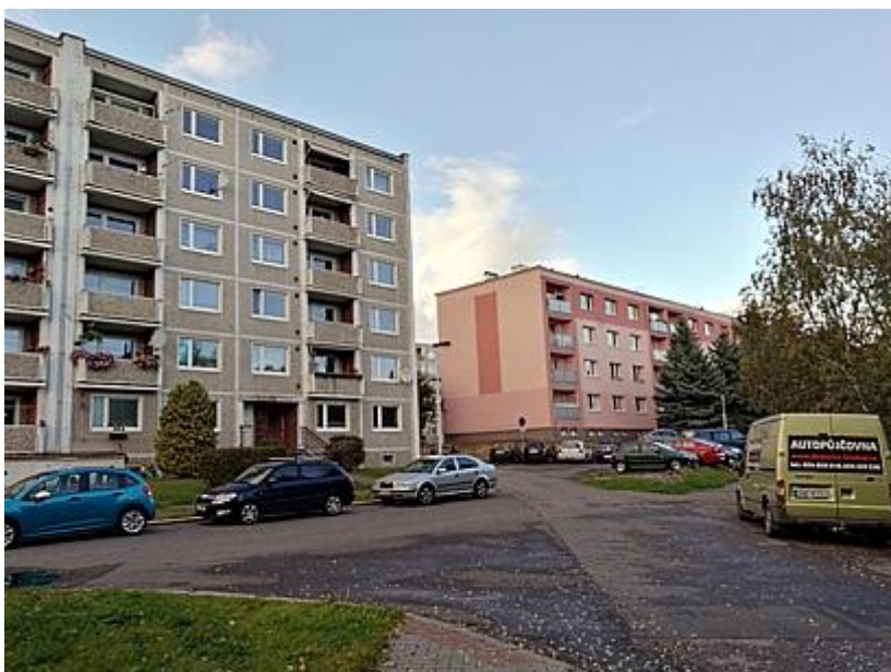
Foto 20 Pohled na jižní stranu spodního bloku sídliště. Ve středu snímku si můžeme všimnout vstupu do vnitrobloku tohoto sídliště a řešení parkovacích ploch pod ním.
