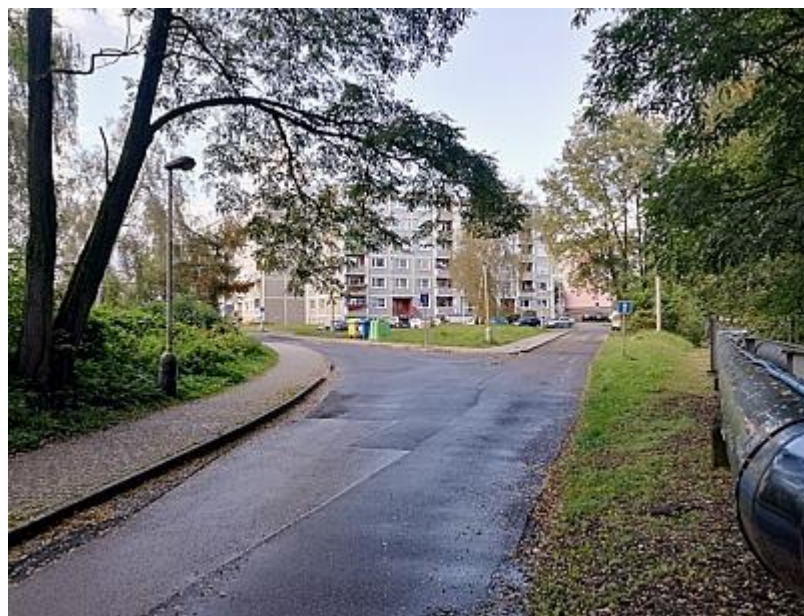
Foto 16 Severovýchodní pohled na vstup do sídliště. Po pravé straně je vidět procházející teplovod. Ve středu snímku je vidět menší parkově upravená plocha před bytovými domy.
