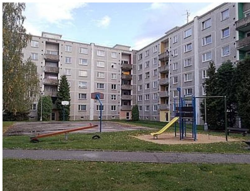
Foto 46 Jižní pohled na asfaltové basketbalové hřiště s prolézačkami, které se nachází v západní části vnitrobloku spodního sídliště. V pozadí je vidět přerostlá zeleň v těsné blízkosti panelového domu, která zastiňuje několik balkónů a oken.
