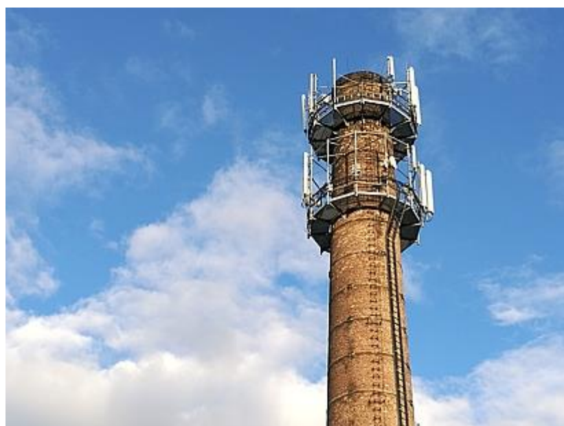
Foto 14 Komín působící jako dominanta této lokality slouží zároveň i jako vysílač. Vlastnický patří k bývalé těžní budově.
