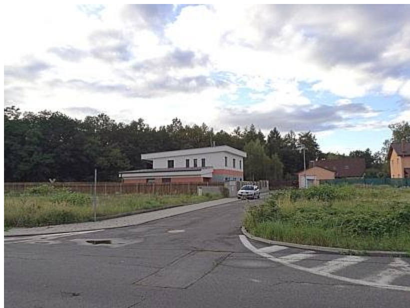
Foto 62 Severozápadní pohled na komunikaci, sloužící jako příjezdová pro několik rodinných domů. Můžeme se povšimnout absence vyznačení cyklostezky i nedostatku chodníků pro pěší.
