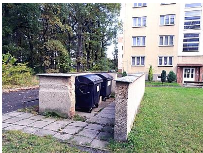
Foto 33 Detail řešení místa pro kontejnery s odpadem. Tyto betonové zídky bychom našli ještě na několika místech v sídlišti.
