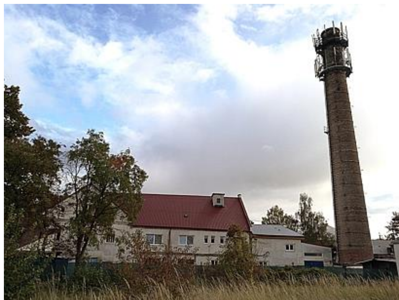
Foto 13 Jižní pohled na bývalou těžní budovu s komínem.
