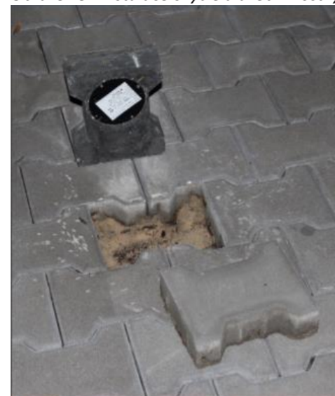
Obrázek 87 Instalace chytré dlažební kostky [44]
