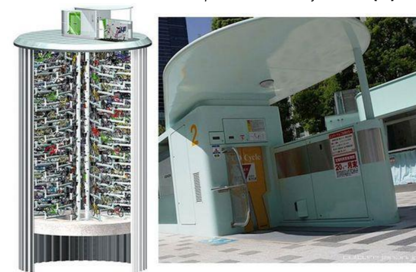
Obrázek 75 Automatizovaná podzemní úschovna jízdních kol [43]
