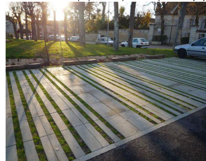
Obrázek 73 Odvodnění propustného zpevněného parkoviště [43]
