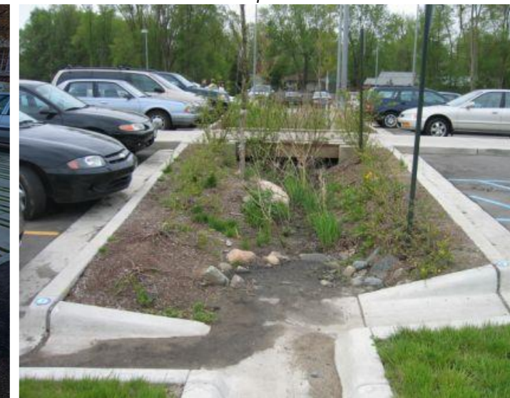
Obrázek 74 Ukázka odvodnění parkoviště dešťovou zahradou
