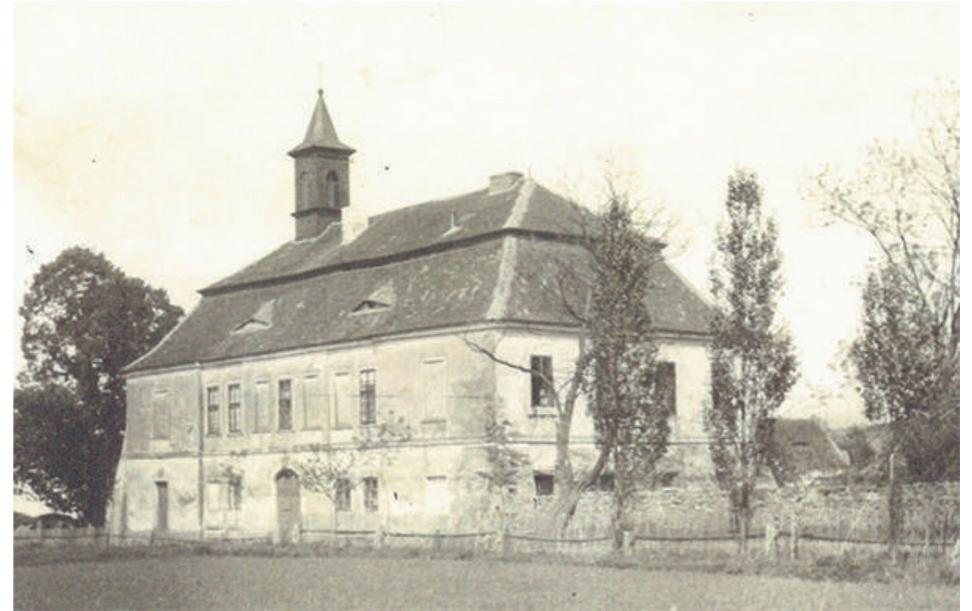
pohled na zámek z ulice, nedatovaná fotografie
