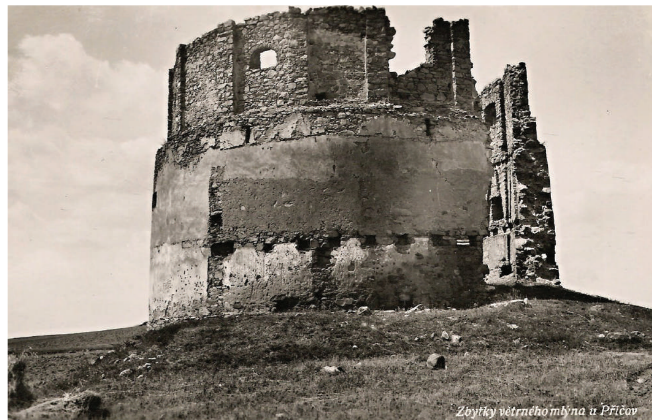
zbytky větrného mlýna u obce Příčov, r. 1932
