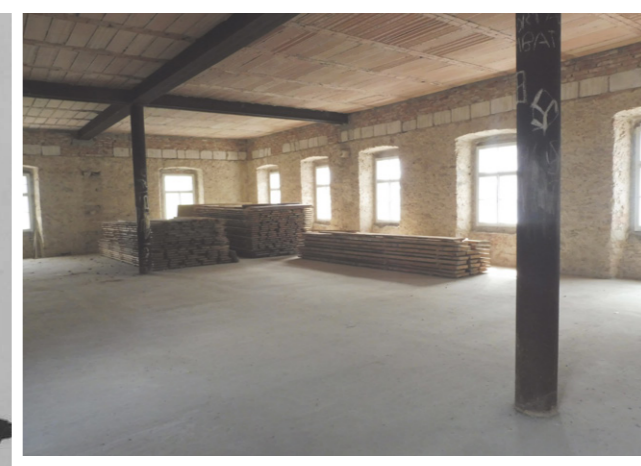
V patře byly zbourány vnitřní stěny.
