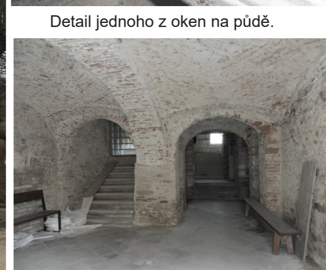
Zbytky schodů v síni přízemí (E.1.4).
