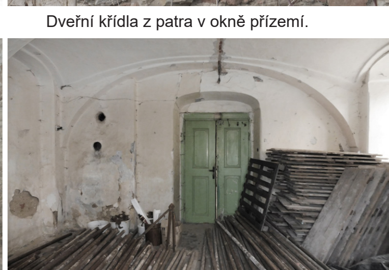
Lešení na dřevěné podlaže (E.1.6).
