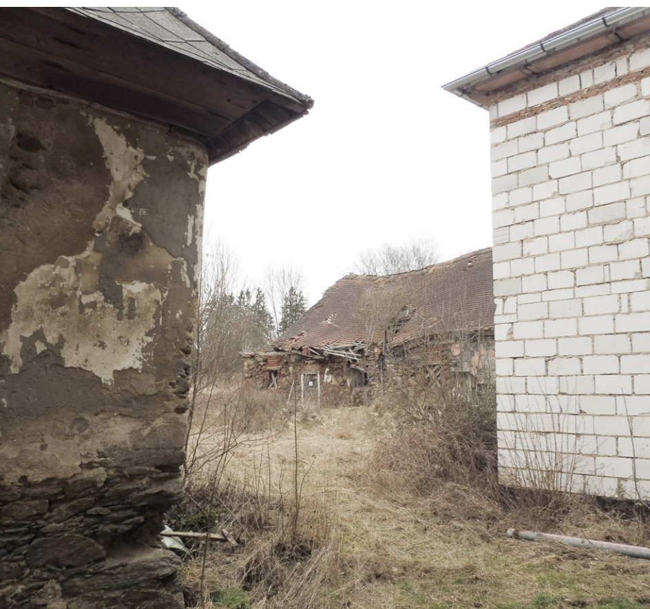
Toto zákoutí vzniklo přístavbou objektu E' z tvárnice.
