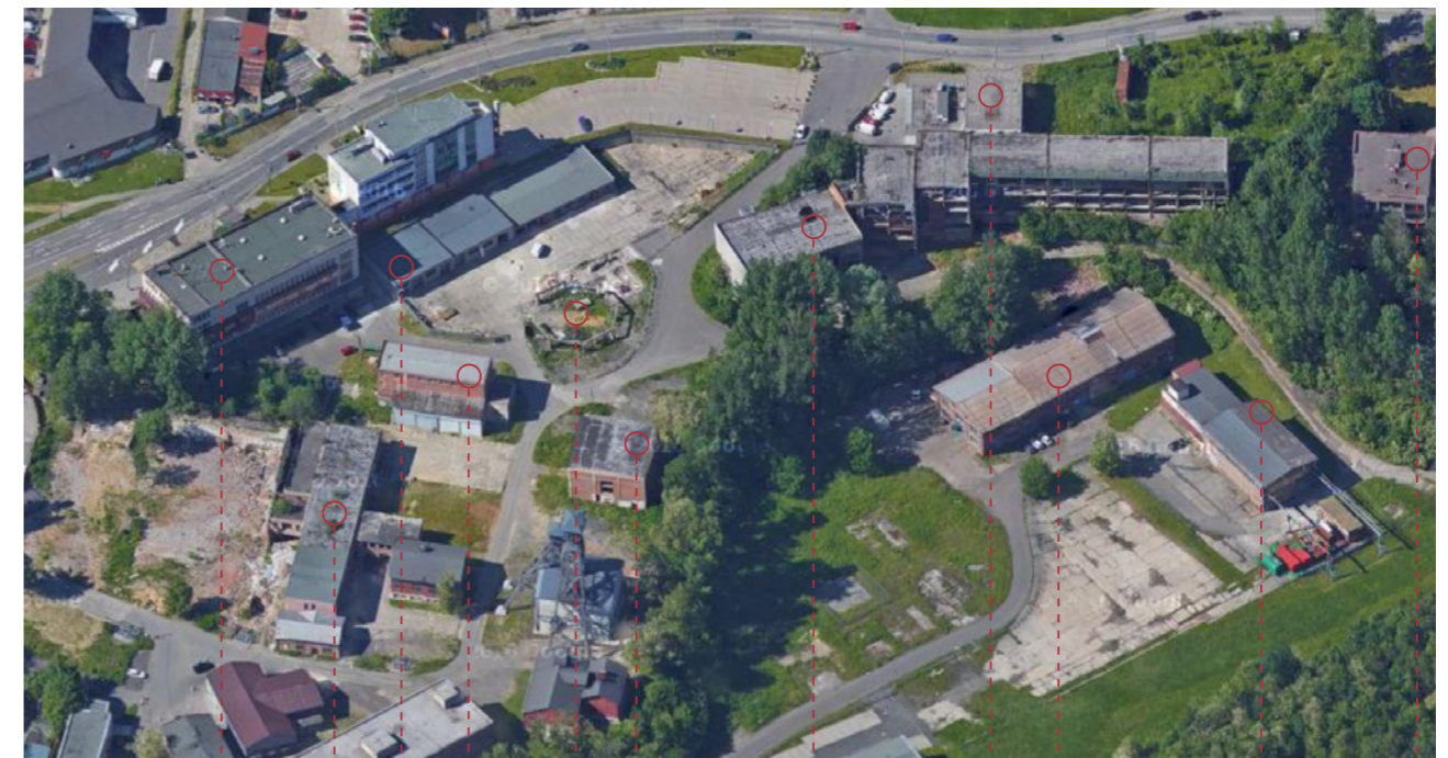
BUDOVA POJÍŠŤOVNY TORZO ŠATEN A STARÉ KOUPELNY PNEUSERVIS TRAFIKANTICE CHLADICÍ VĚŽ KOMPRESOROVNA SODNIKARNA/ ROZVODNA STRANOVACÍ A ÚKLIDOVÁ FIRMA AUTODÍLNA AUTODÍLNA PANELOVÉ BYDLENÍ
