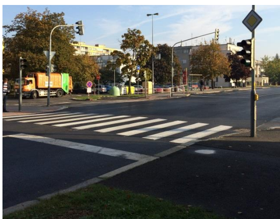
Obr. D40 – Přečhod pro chodce, západní rameno; hmatové úpravy zřízeny pouze na SZ nároží
