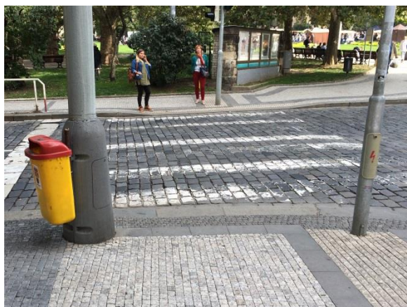
Obr. D27 – Přejchod pro chodce, severní rameno
