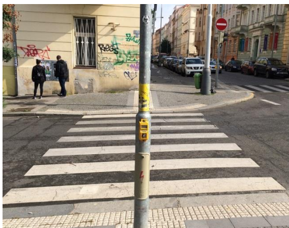
Obr. D18 – Přečhod pro chodce, severní rameno; hmatové a bezbariérové úpravy v pořádku
