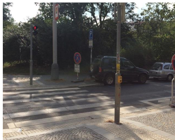
Obr. D19 – Přečhod pro chodce, západní rameno; hmatové a bezbariérové úpravy v pořádku
