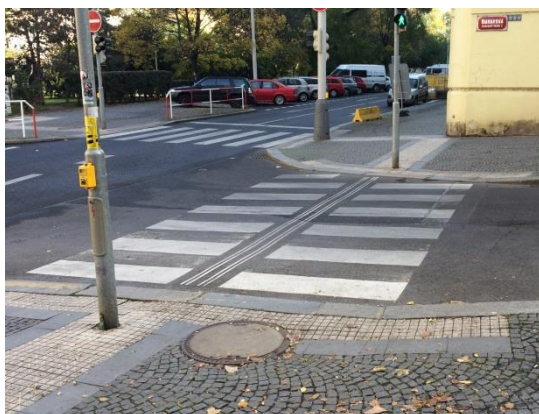
Obr. D14 – Přečhod pro chodce, jižní rameno; hmatové a bezbariérové úpravy v pořádku
