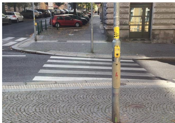
Obr. D15 – Přečhod pro chodce, západní rameno; přečhod není pro nevidomé určen (pouze varovný pás)
