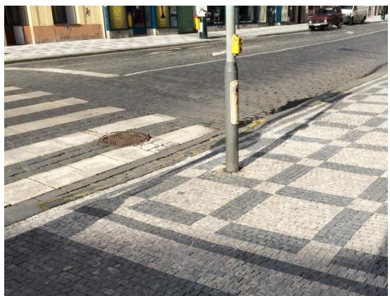
Obr. D10 – Přejchod pro chodce, severní rameno (SV nároží), hmatové úpravy nezřízeny
