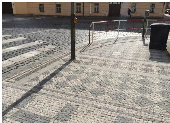
Obr. D11 – Přejchod pro chodce, severní rameno (SZ nároží), hmatové úpravy zřízeny
