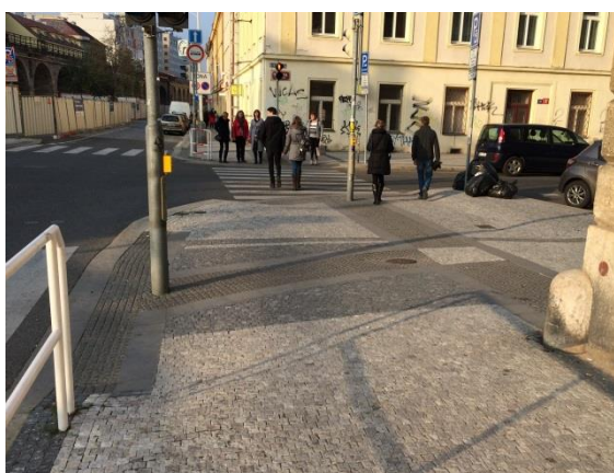
Obr. D81 – JV nároží, detail hmatových úprav
