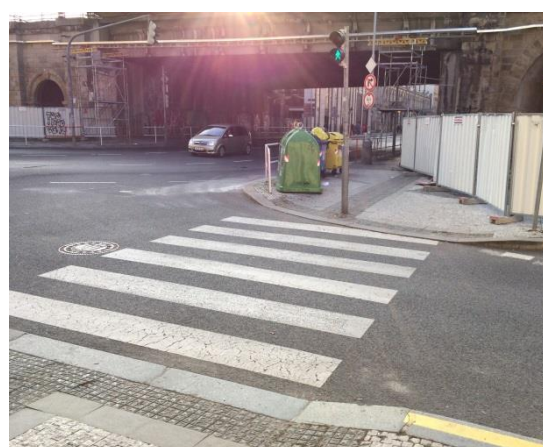
Obr. D84 – Přechod pro chodce, severní rameno, probíhající stavební úpravy mostu
